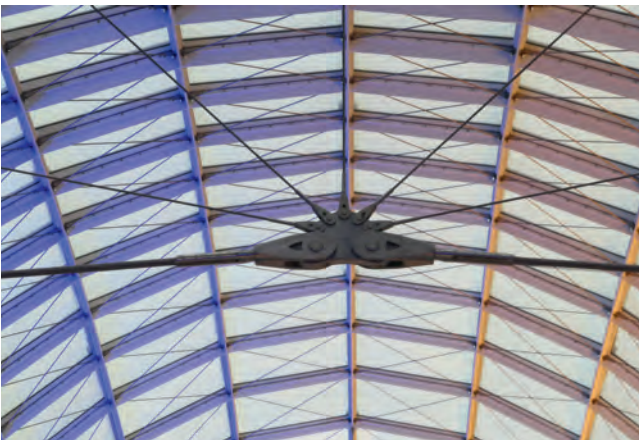
Bild 4 Radial verlaufende Seilkonfiguration zur Aussteifung (© schlaich bergemann partner)
