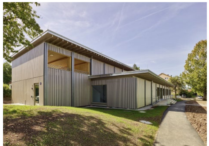
Bild 2. Das Schulgebäude in Dresden Seidnitz wurde wie zahlreiche Kindertagesstätten in klimafreundlicher Holzmodul-/Elementbauweise geplant und errichtet.
