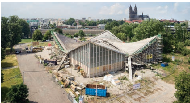
Bild 8 Verstärkung der Hyparschale Magdeburg Strengthening the Hyparschale in Magdeburg
