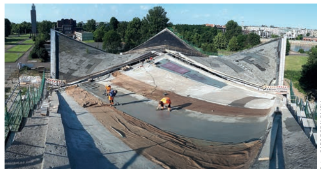
Bild 9 Ausführungsarbeiten mit Carbonbeton Strengthening with carbon reinforced concrete
