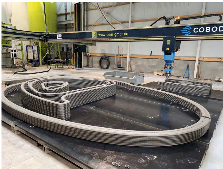
Bild 2 Die Technik bei der Röser GmbH in Laupheim stammt von Technologieführern aus dem Betonbau – der 3D-Drucker ist eine Kooperation von COBOD und PERI.
