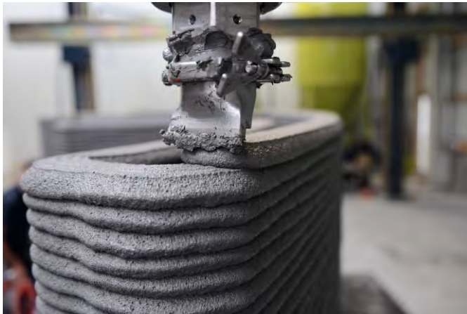
Bild 1 Der zementfreie Druckmörtel muss ein thixotropes Verhalten aufweisen, das heißt, solange dem Material Energie zugeführt wird, ist es verformbar und pumpbar, ohne Energiezufuhr hingegen ist es standfest.
