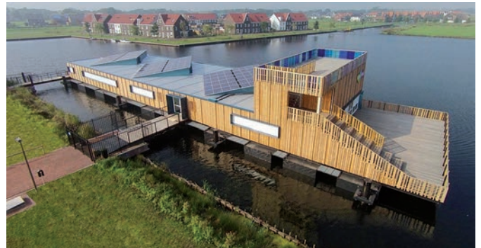
Bild 1. Schwimmendes Info-Zentrum aus ELA-Containern mit Holzverkleidung in Naturoptik (Foto: ELA)
