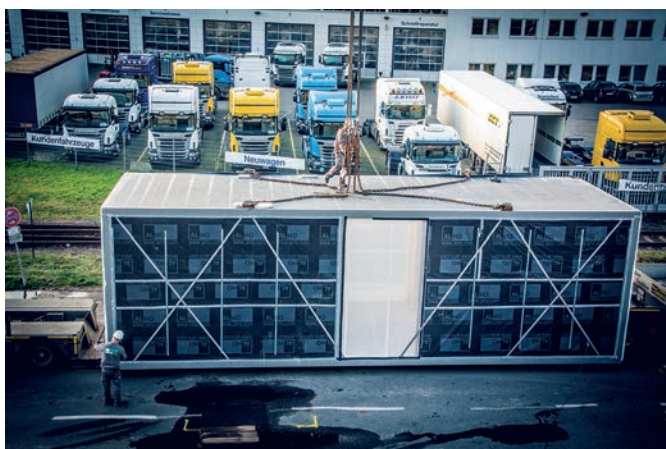
Bild 2. Jedes Modul besitzt eine freitragende, in sich statisch stabile Stahlskelettstruktur, die mit Böden, Decken und Wänden in Leichtbauweise komplettiert wird.
