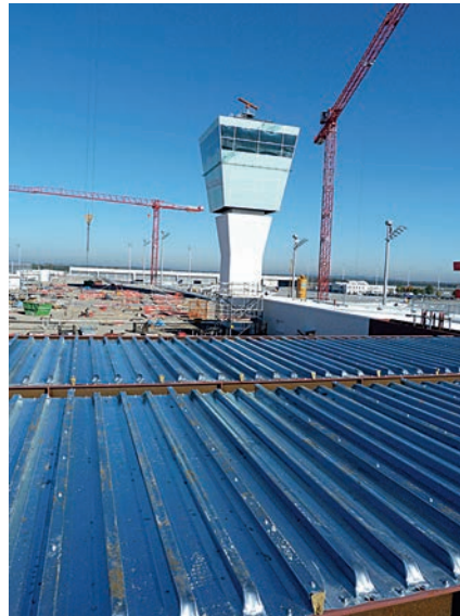
Bild 2. Für das neue Gebäude wurden 56.000 m 2 Metallverbundprofile der Montana Bausysteme AG verwendet
