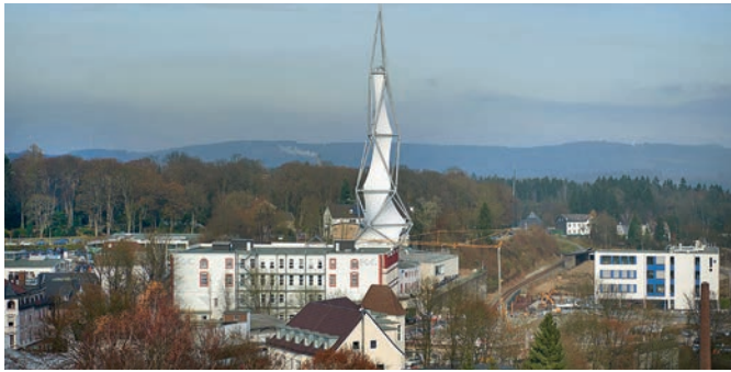
Bild 1. Klare Optik dank eines von Stabdreiecken gebildeten, schlanken Stahl-Fachwerks aus luftdicht verschweißten Rundrohr-Hohlprofilen (Foto: Rutzen)
