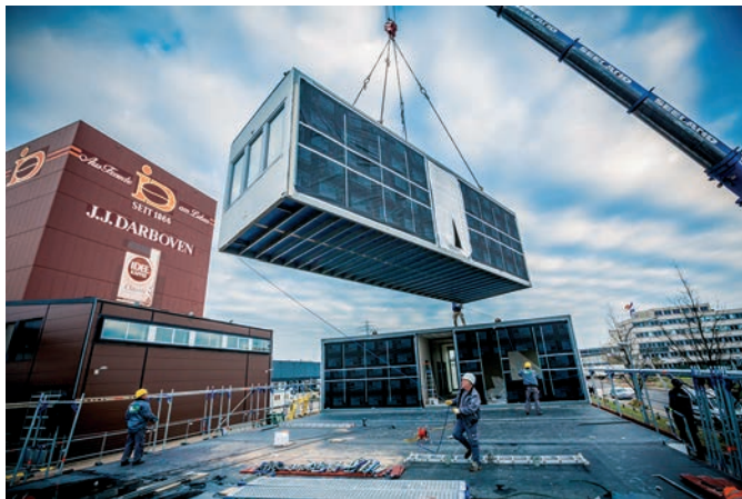
Bild 3. Beginn der Modul-Montage KW 49/2015 – Fertigstellung bis zur Übergabe in KW 9/2016, was abzüglich der Weihnachtsfeiertage, in denen die Baustelle ruhte, 12 Wochen Bauzeit ergab. (Fotos: ALHO Holding GmbH)
