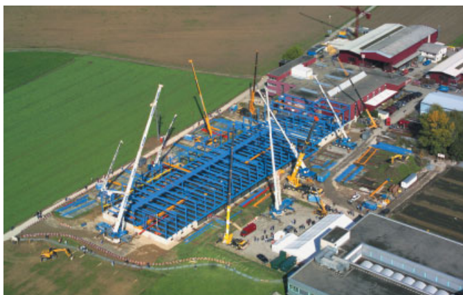
Bild 11. Montage einer neuen Produktionshalle in 19 Stunden
