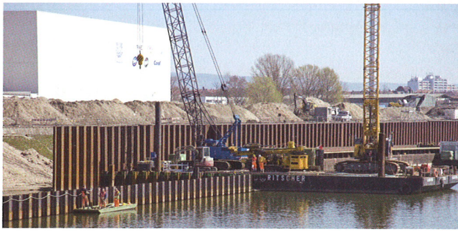
Bild 2. Sicherung des Ufers mit einer Spundwand
