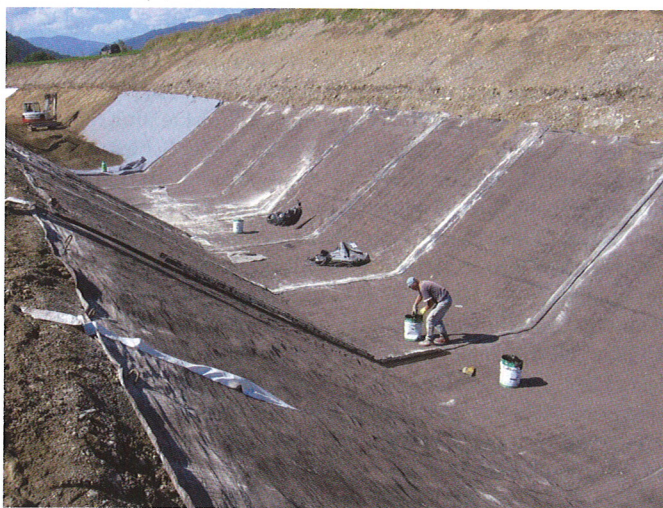
Bild 1. Die Antwort auf steile Böschungen lautet „sandraue“ Beschichtung; nach der Verlegung der GTD Typ NaBento® RL-C werden die Überlappungsbereiche mittels Spezialkleber dicht und schubfest verbunden
