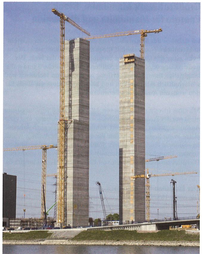
Bild 3. Betonage der beiden Treppentürme, später die wichtigsten Zugänge für das Kessel- und Maschinenhaus (Fotos: GKM Großkraftwerk Mannheim)
