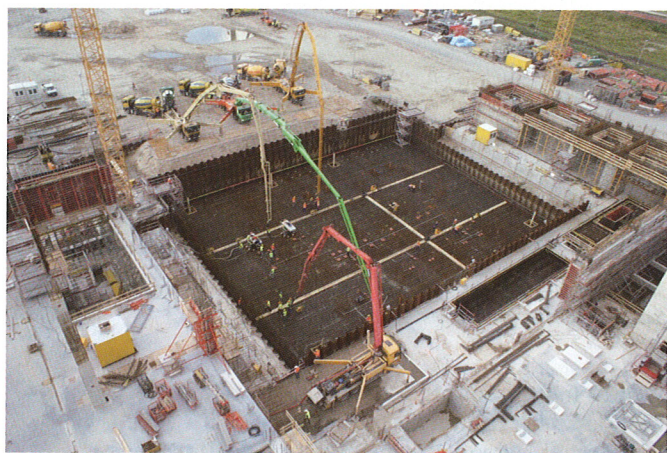
Bild 1. Die mit 63 m größte Betonpumpe Europas wurde angefordert, um die Betonage der gigantischen Kraftwerks-Gründungsbauteile durchführen zu können
