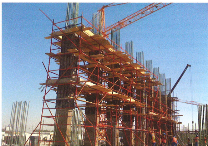
Die doppelt geschosshohen, insgesamt 9 m hohen Pfeiler wurden mit einer 5 m hohen Pfeilerschalung in zwei Betoniertakten erstellt; es waren keinerlei Restmaßausgleiche erforderlich, also waren Arbeitsgeschwindigkeit hoch und Betonbild bestens
