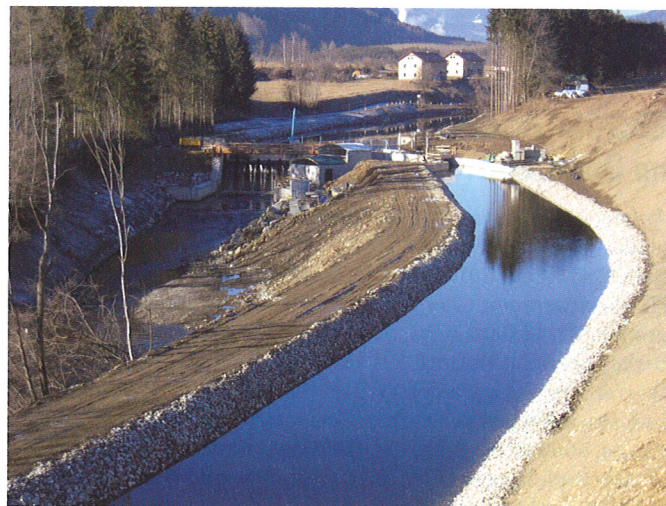
Bild 4. Der naturnah gestaltete Oberwasserkanal „Wasserkraftwerk Ritzersdorf“ nach Fertigstellung der Abdichtung und Anschluss an das Entnahmebauwerk (Fotos: HUESKER Synthetic)
