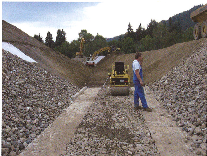
Bild 2. Die auf 2,0 km Länge mit NaBento® RL-C und dem HaTe®-Schutzwvlies Typ E 650 hergestellte Kanalabdichtung ist setzungsunempfindlich und kostengünstig
