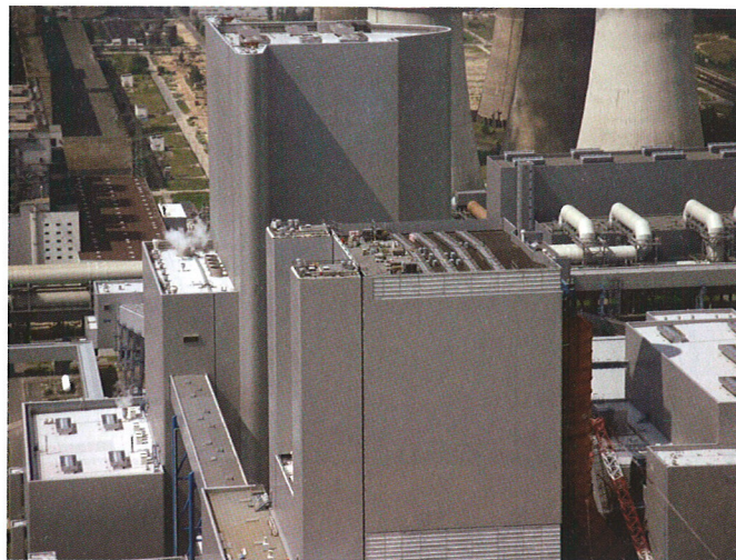
Bild 2. Für die Fassadenverkleidung kamen Stahlleichtbauelemente mit einer ZM EcoProtect-Beschichtung zum Einsatz (Fotos: ThyssenKrupp Steel Europe)
