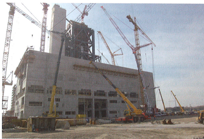
Bild 2. Der Rohbau der Turbinenhalle kurz vor der Fertigstellung
