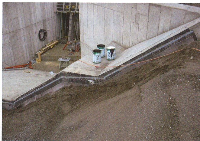
Bild 3. Die GTD NaBento® RL-C wird mit Nirosta-Schienen sauber und problemlos an bestehende Bauwerke angeschlossen
