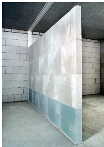
Bild 1. Aufbau einer massiven Gipswand im Gebäude Fig. 1. Solid gypsum wall in a building
