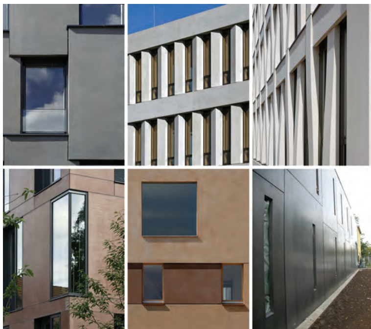
Abb. 7.1 Fassaden aus Architekturbeton (Fotos: FDB-Mitgliedsunternehmen).
