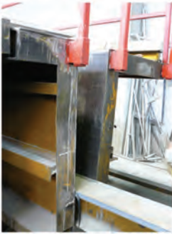
Abb. 2.10 Schalung einer TT-Platte.
