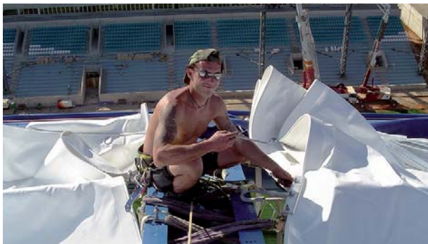
Abb. 104: Vorbereiten von Membranrandausbildungen zum Spannvorgang
