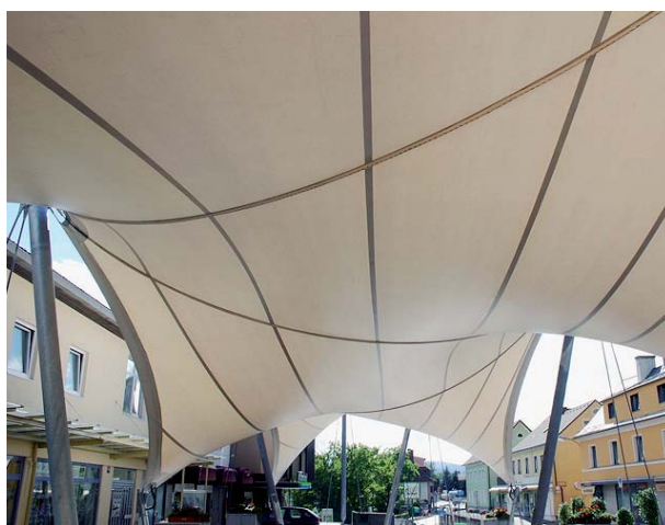
Abb. 95: Diagonal verlaufende Sogseile an der Unterseite einer Segelfläche
