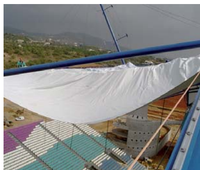
Abb. 101: Einziehen und Spannen der Membrane für die Tribünenüberdachung im Stadion Faro, Portugal
