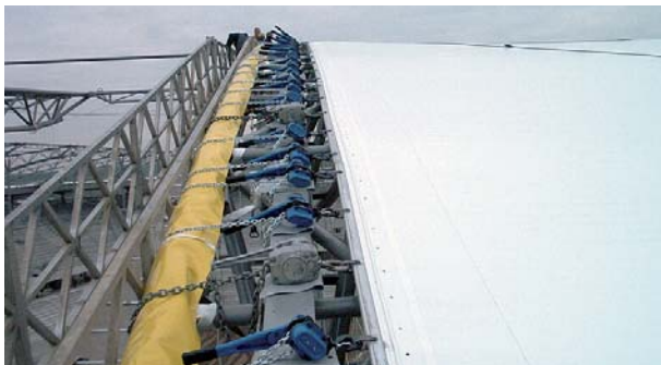
Abb. 100: Einziehen und Spannen der Membrane für die Tribünenüberdachung im Stadion Wolfsburg
