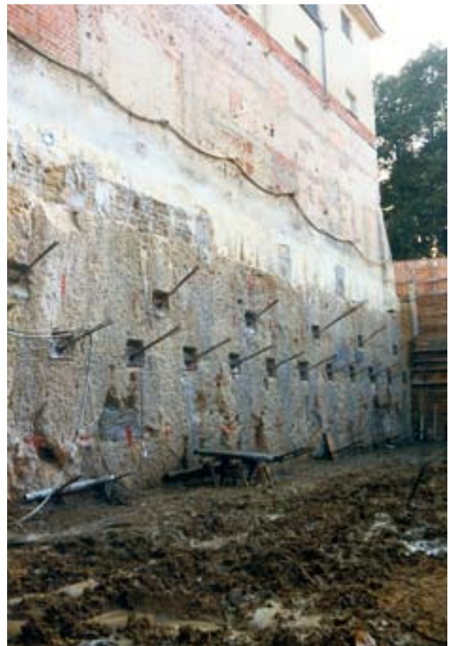
Mehrfach verankerte Unterfangungswand
