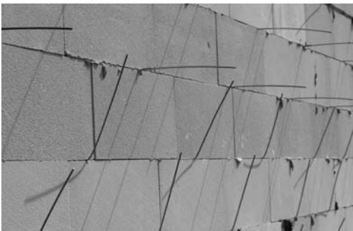
Bild 13. Wird die tragende Innenschale mit Leichtmörtel hergestellt, dürfen keine Rundanker verwendet werden
