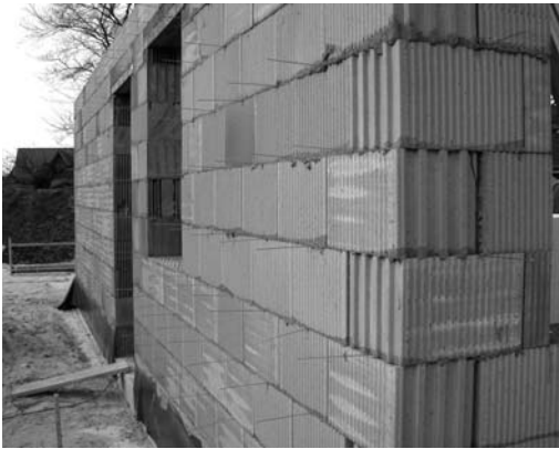
Bild 8. Beispiele für flächenhafte Verankerungen
