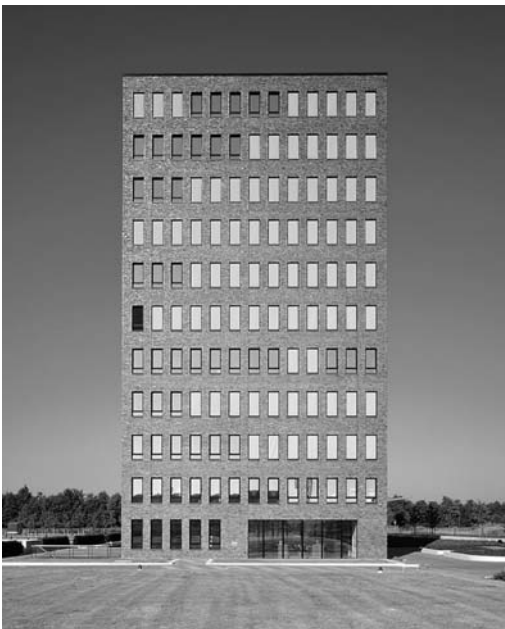
Bild 5. Hochhaus in Greven mit einer Klinker- verblendschale, Oldenburger Format (OF 220 mm × 220 mm × 52 mm)
