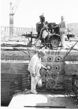
Bild 65. Einpressen von Spanngliedern mit nachträglichem Verbund
