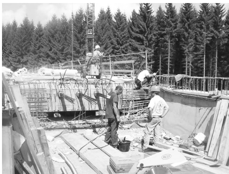
Bild 64. Vorspannarbeiten auf der Baustelle
