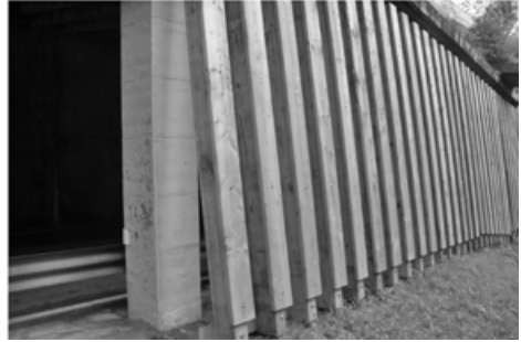
Bild 7-35 Verschiedene Varianten der talseitigen Verschalung der Öffnungen von Lawinengalerien: (a): Verschalung mit Betonbalken; (b): Verschalung in Holz (© Sauermoser)
