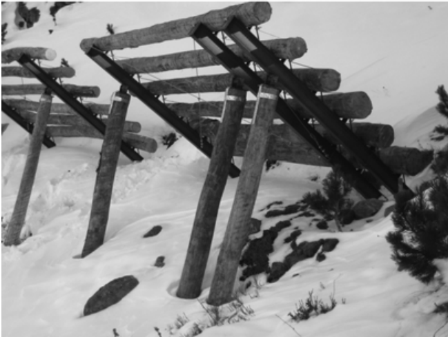
Bild 7-10 (Fortsetzung) Kombinierte Schneebrücken D 2,5 mit Robinienholzbedielung: Österreichisches System (d): Bautype (© Fa. CrestaGeo)
