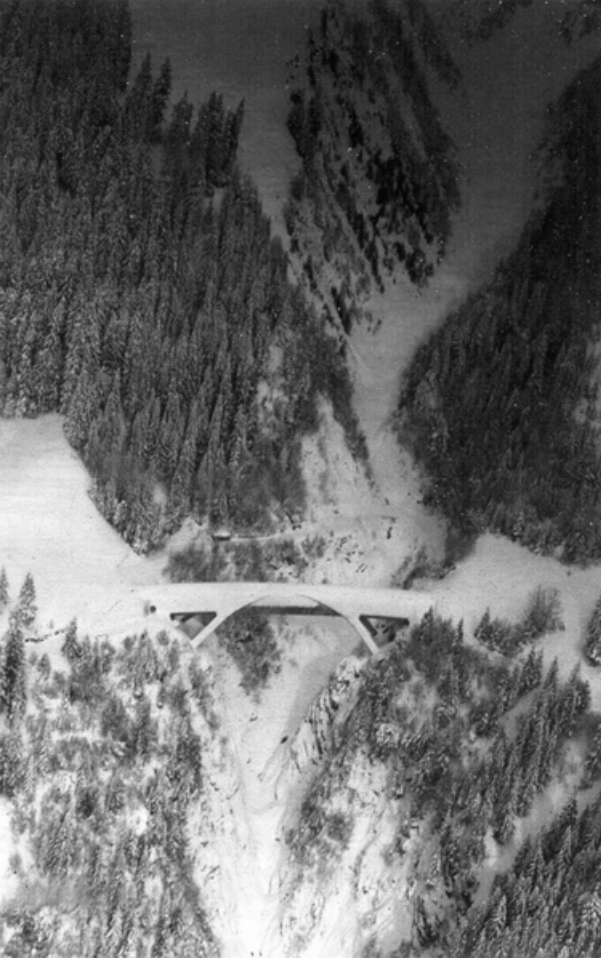
Bild 7-36 Rohrbrücke im Großen Gröben (Blaberstrasse/Tirol) (© WLV Tirol)
