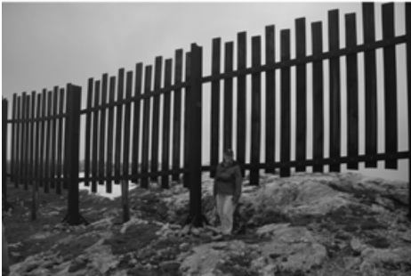
Bild 7-21 Tribschneezäune: (a): mit Holzbedielung und unregelmäßiger Abrisskante und (b): mit horizontaler Stahlbedielung (© Sauermoser)
