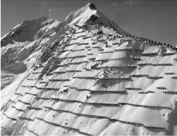
Bild 7-20 Kombination einer Lawinenanbruchverbauung mit Kolktafeln in Kammlage (© WLV Vorarlberg)
