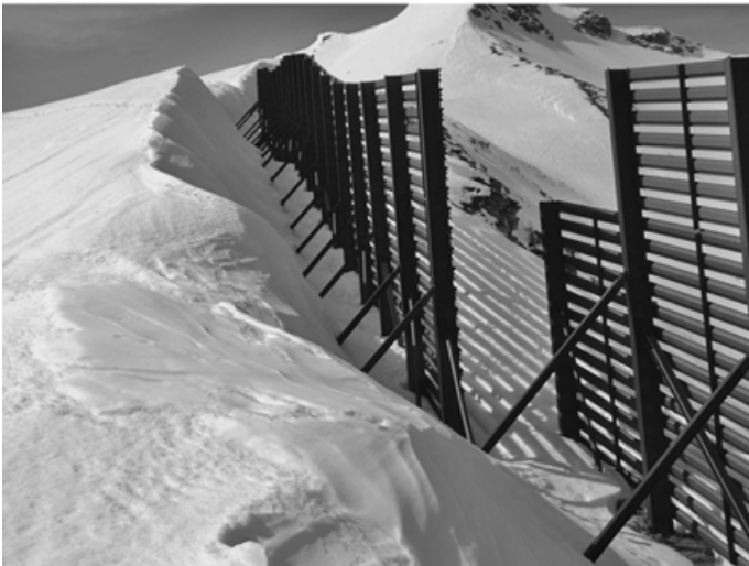
Bild 7-1 (a): Lawinenanbruchverbauung mit Stahlschneebrücke: Lawine Heiligenblut (Kärnten) (© Sauermoser) und (b): Verwehungsverbauung: Triebschneezäune in Stahl (© WLV Salzburg)
