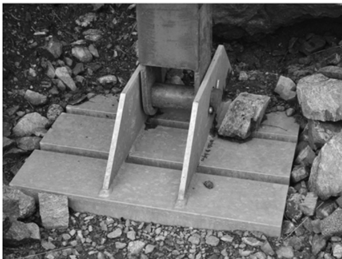
Bild 7-16 Fundierung eines Stahlstützwerkes: (a): bergseitig mittels auf Zug und Druck beanspruchten Mikropfählen und (b): talseitig mittels Grundplatte in Stahl (© Rudolf-Miklau)
