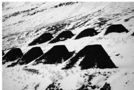
Bild 7-32 Lawinenbremsverbauung: (a): Bremskegel in der Heiligenblutlawine (Kärnten); (b): Bremshöcker in Neskaupstadir (Island), bemessen nach [147] © Sauermoser
