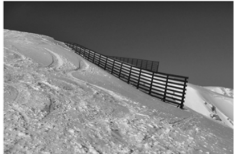
Bild 7-21 Tribschneezäune: (a): mit Holzbedielung und unregelmäßiger Abrisskante und (b): mit horizontaler Stahlbedielung (© Sauermoser)
