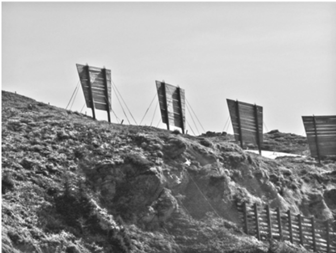
Bild 7-23 Kolktafeln: (a): Kolktafeln aus Holz entlang eines Gratrückens auf dem Jaufenpass (Südtirol) (© Sauermoser)
