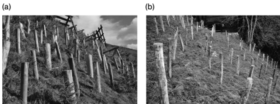
Bild 7-26 Verpfählungen: (a): ohne Verspannung (Gesamtlänge der Pfähle: 1,5 m, Wirkhöhe 0,5–0,75 m) (© Sauermoser); (b): Verpfählung vorgespannt (© WLV Tirol)
