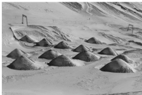
Bild 7-32 Lawinenbremsverbauung: (a): Bremskegel in der Heiligenblutlawine (Kärnten); (b): Bremshöcker in Neskaupstadir (Island), bemessen nach [147] © Sauermoser
