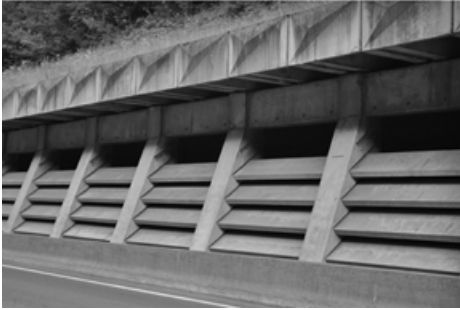
Bild 7-35 Verschiedene Varianten der talseitigen Verschalung der Öffnungen von Lawinengalerien: (a): Verschalung mit Betonbalken; (b): Verschalung in Holz (© Sauermoser)
