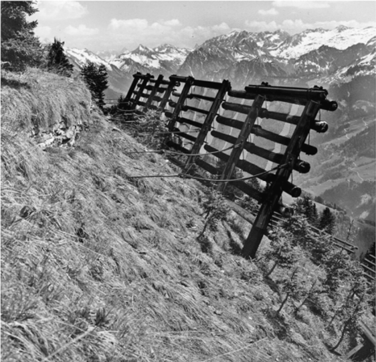
Bild 7-14 Schneehängebrücke: Werk D = 2,5 mit Holzbedielung (© WLV Vorarlberg)
