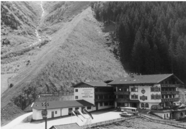
Bild 7-30 Ablenkbauwerke: (a): Lawinenablenkmauer in Stahlbeton (© Sauermoser) und (b): Ablenkdam (© WLV Tirol)
