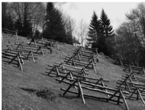
Bild 7-4 (a): Schneebrücken in Stahl in geschlossenen Werksreihen: Bachertallawine (Neustift im Stubaital, Tirol) (© Rudolf); (b): Holzschneebrücken (© Schilcher)
