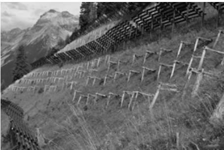
Bild 7-25 Kombination von Lawinenanbruchverbauung mit technischen Gleitschneeschutzmaßnahmen (Gleitschneeböcke) in der Lenzerwaldlawine (Tirol) (© Rudolf-Miklau)
