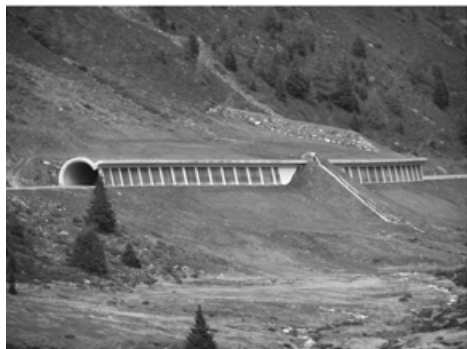
Bild 7-34 Überleitungsbauwerke: (a): Lawingalerie in Kühtai (Tirol); (b): im Bau befindliche Galerie in der Mahdermähderlawine (Schmirntal/Tirol) (© Sauermoser)
