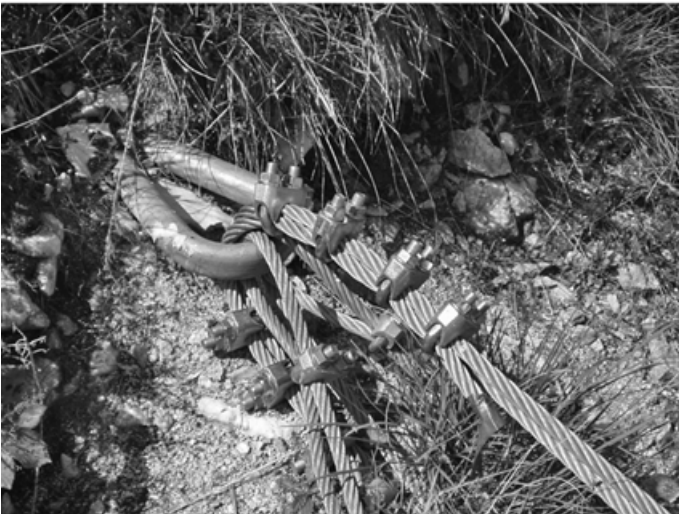
Bild 7-18 Verankerung von Lawinennetzen: (a): Seilanker zur bergseitigen Fundierung von Lawinennetzen – Ankerkopf mit Abspannseilen
