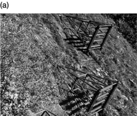
Bild 7-15 (a): Aufgehängtes Glarner Hängewerk und (b): Ombrello Lawinenstützwerk (© Margreth)
