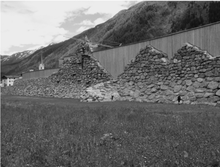
Bild 7-31 Zweiteilige, massiv ausgeführte Lawinenmauer zum Schutz des Ortszentrums von Galtür (Tirol): (a): im Überblick; (b): von der Anströmseite gesehen mit dem dahinterliegenden Alpinarium (© WLV Tirol)
