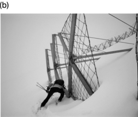
Bild 7-15 (a): Aufgehängtes Glarner Hängewerk und (b): Ombrello Lawinenstützwerk (© Margreth)
