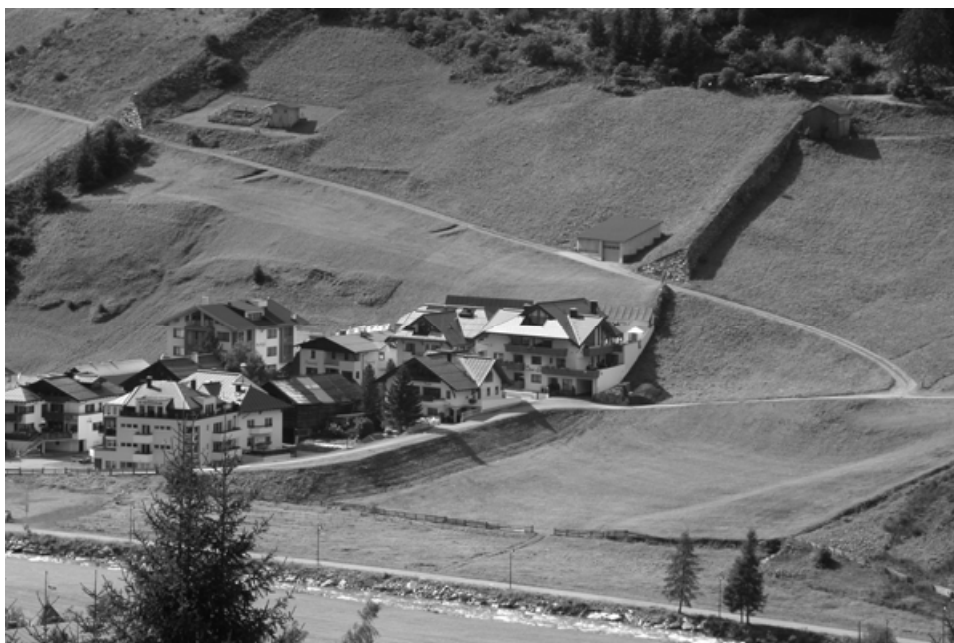
Bild 7-29 Leitdämme verhindern die seitliche Ausbreitung von Fließlawinen in Richtung des Siedlungsraums (Ischgl/Tirol) (© Rudolf-Miklau)
