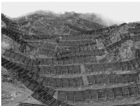
Bild 7-4 (a): Schneebrücken in Stahl in geschlossenen Werksreihen: Bachertallawine (Neustift im Stubaital, Tirol) (© Rudolf); (b): Holzschneebrücken (© Schilcher)
