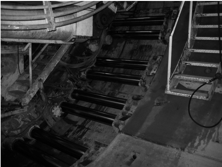
Bild 3-6 Vortriebspresen und Pressenschuhe, Mixschild Finnetunnel, 2009 (Herrenknecht)
