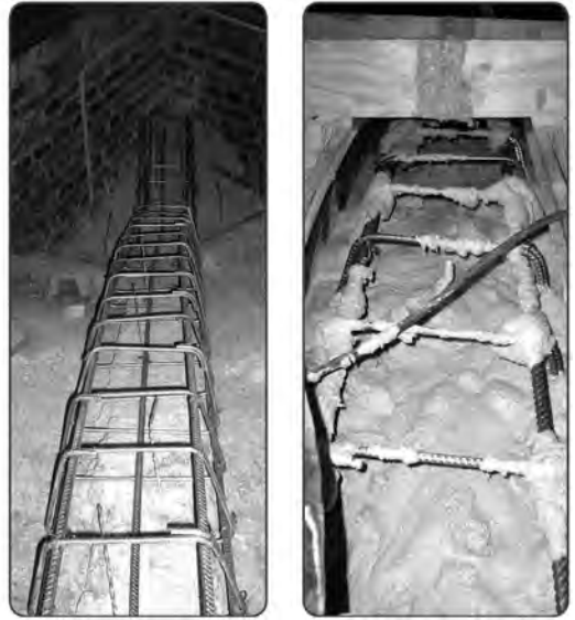
Bild 7. Einbau sogenannter Oberlastrippen mit Rückverankerung der Natursteinrippen mittels Doppel-Wendelankern [9]
