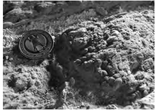
Bild 4. Zustand (Restquerschnitt teilweise nur noch etwa 5 bis 6 cm stark) des Gewölbemauerwerks (Gewölberücken) nach Abnahme des Wärmedämmmörtels und Reinigung
