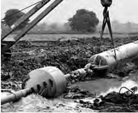
Bild V-1. Einziehen des Rohrstrangs [11]
