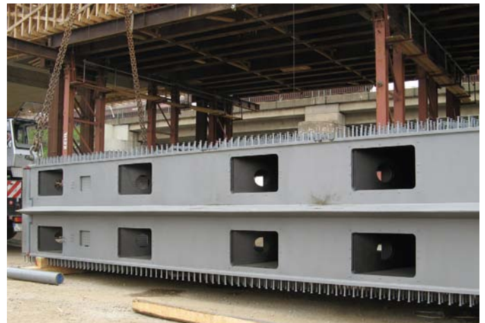
Bild 5.6 Stahlkammern zur Kabelverankerung
