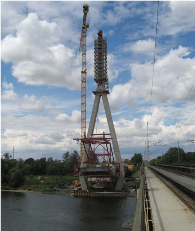
Bild 5.8 Eingerüsteter Pylonkopf
