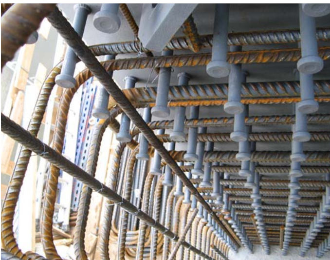
Bild 5.9 Bewehrung der Betonseiten an den Stahlkammern
