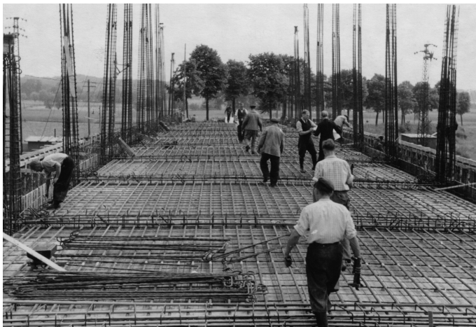
Bild 95. Bewehrungsarbeiten an der Hünxer Brücke im Jahre 1951, Bildquelle: Bundesanstalt für Wasserbau (BAW) [30]
