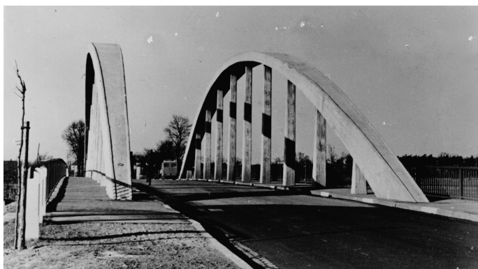
Bild 96. Baugleiche Bogenbrücken; a) Hiltruper Brücke, b) Brücke in Dinslaken, Bildquelle: Bundesanstalt für Wasserbau (BAW) [30]
