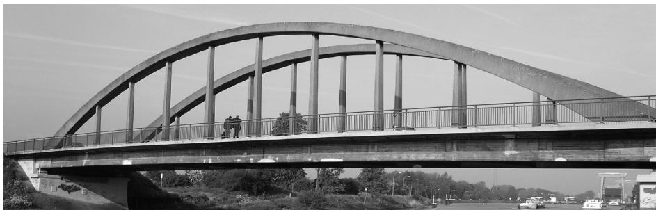
Bild 94. Hünxer Brücke kurz vor dem Rückbau
