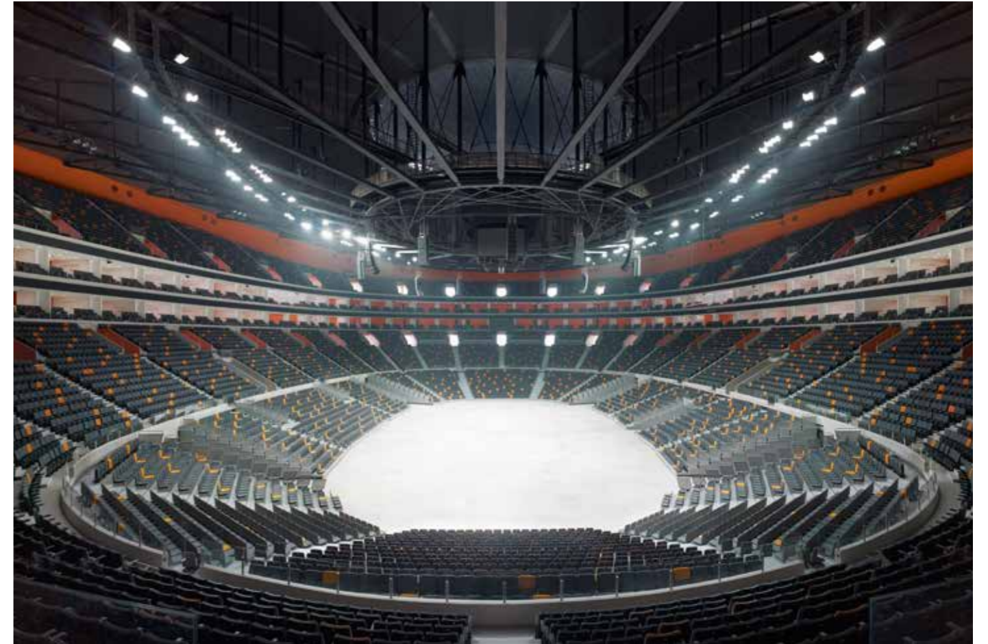
3 Offene Nabe mit verfahrbarem Videowürfel
