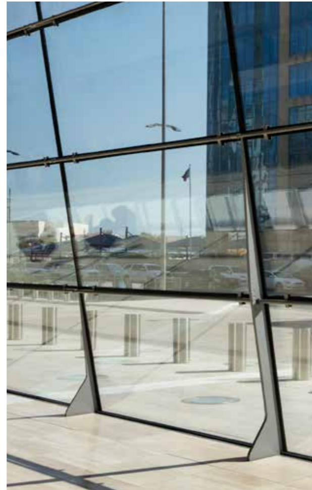
7 Detailansicht des Klemmhalters 8 Explosionszeichnung eines Klemmhalters 9 Stahlschwerter reduzieren lokal auftretende Verwindungen. 10 Blick vom Eingangsbereich auf die Skyline von Doha
