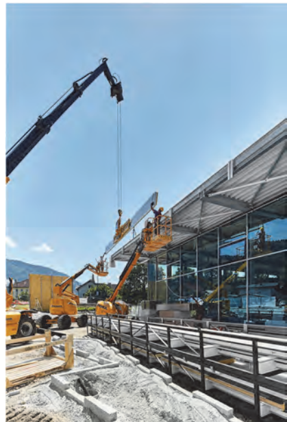
Bild 2-2 Neue Kombinationen großer Gläser geklebt auf Sandwichelemente bieten sehr guten Wärmeschutz bei gesteigerter Ästhetik, 2016 (Elementlänge 14,72 m, Bildnachweis: icnoic skin GmbH).
