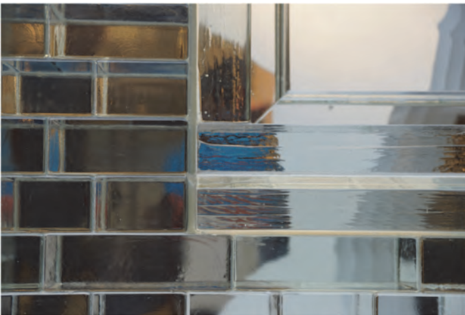
Bild 2-5 Glassteine am Crystal House in Amsterdam, 2016 (Bildquelle: U. Knaack), [9].
