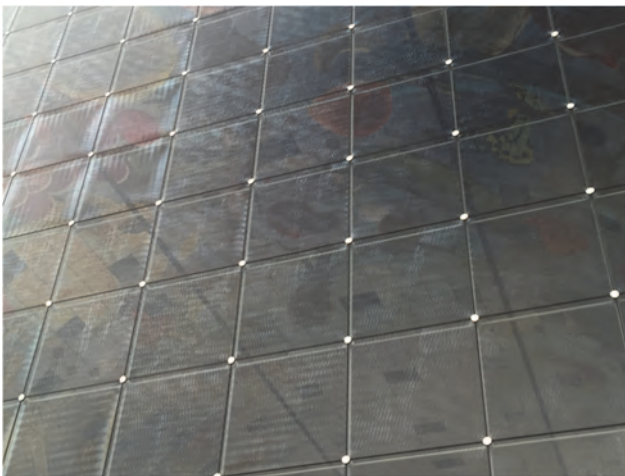
Bild 2-10 Optische Anisotropien bei thermisch vorgespanntem Glas in einer Seilnetzfassade.
