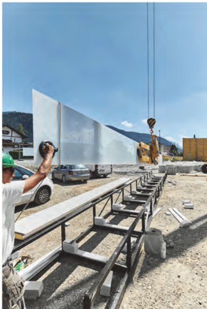
Bild 2-2 Neue Kombinationen großer Gläser geklebt auf Sandwichelemente bieten sehr guten Wärmeschutz bei gesteigerter Ästhetik, 2016 (Elementlänge 14,72 m, Bildnachweis: icnoic skin GmbH).
