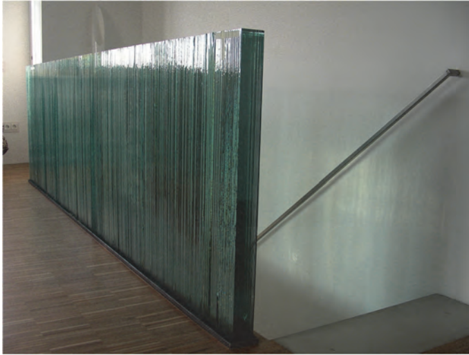
Bild 2-6 Gestapeltes Flachglas als absturzsichernde Verglasung, 2009.
