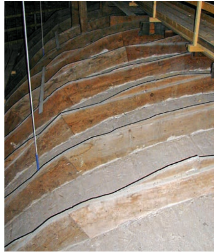
Bild 3.5 Zuschneiden und Zusammennageln einer Büge aus zwei Lagen Brettern (Sax 1814)
