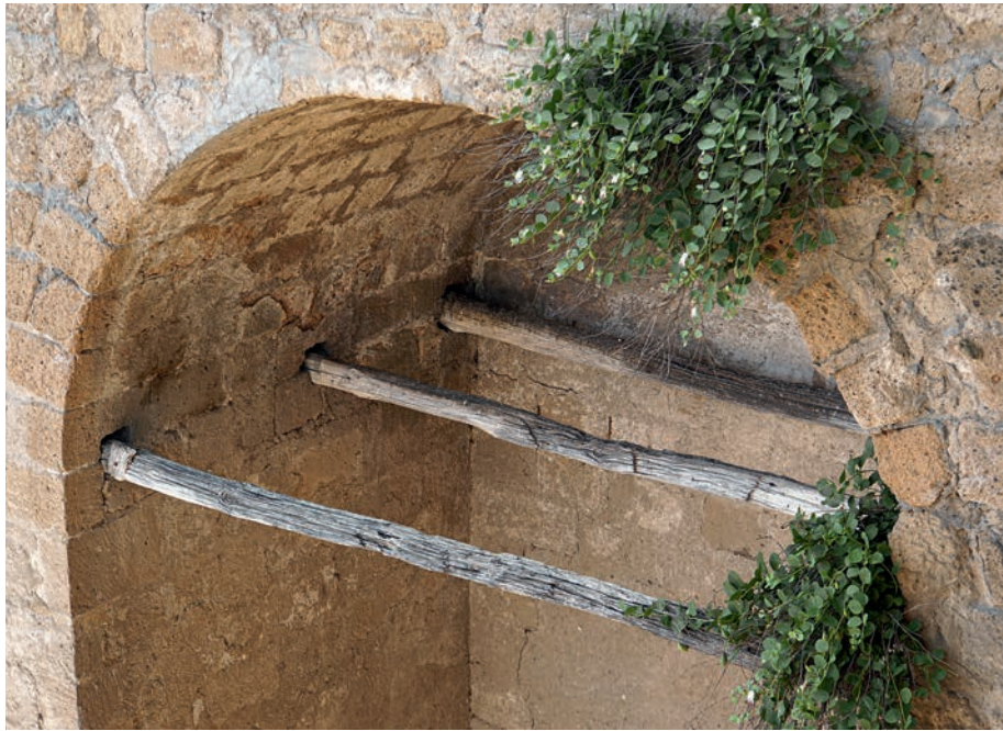
Bild 3.8 Reste dreier einfacher Lehrbögen an der Porta Soliana in Orvieto (wohl um 1450)
