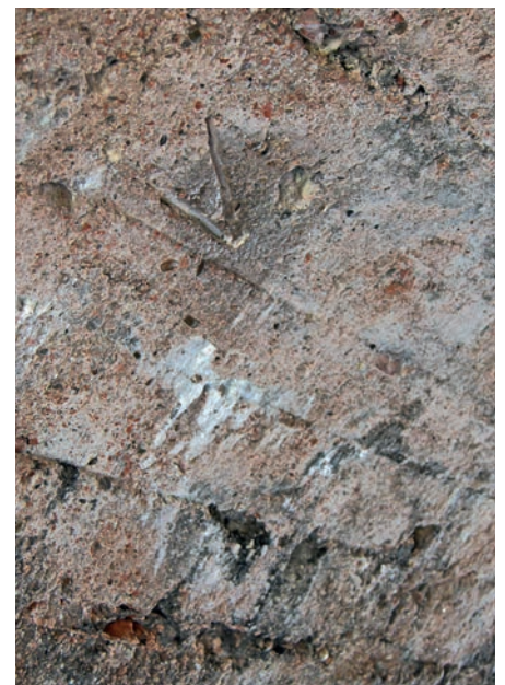
Bild 3.18 Trier, Kaiserthermen, Abdruck eines auf der Brettschalung des Tonnengewölbes vergessenen Zirkels
