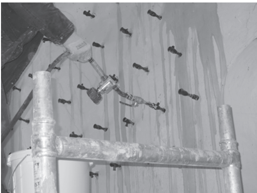
Bild 25. Mauerwerksinjektion mit mineralischen Injektionsmitteln
