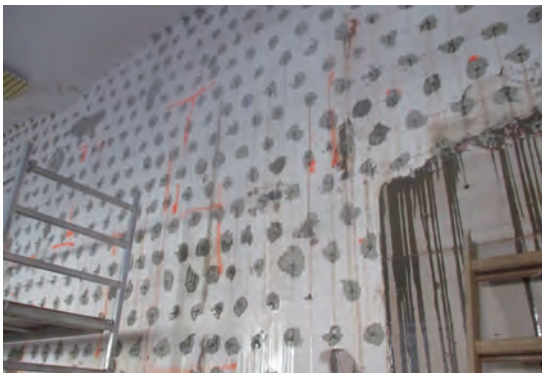
Bild 28. Mauerwerksinjektion mit organischen Injektionsmitteln
