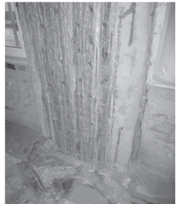
Bild 29. Probleme bei der Ausführung von Injektionen bei schlechter Verdämmung der Wandoberflächen
