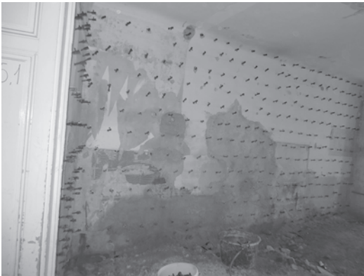
Bild 24. Injektionspacker – Zementinjektion
