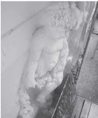
Bild 29. Probleme bei der Ausführung von Injektionen bei schlechter Verdämmung der Wandoberflächen
