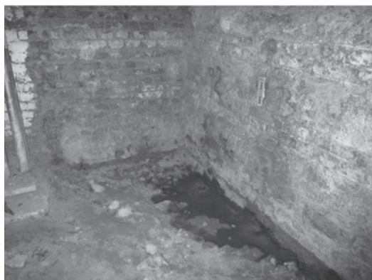
Bild 26. Zementinjektion im Fundamentbereich
