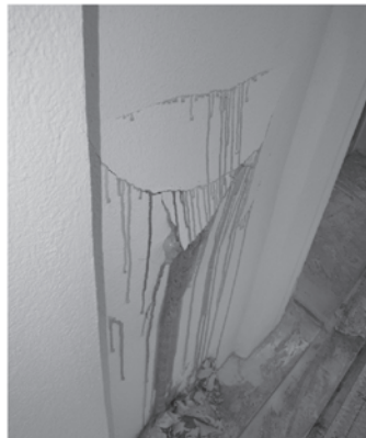
Bild 29. Probleme bei der Ausführung von Injektionen bei schlechter Verdämmung der Wandoberflächen
