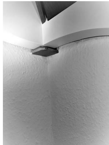
Bild 16. Elastische Lagerung einer Treppenwange auf einer Konsole
