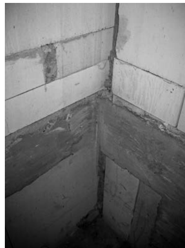
Bild 19. Geschossdecke überbrückt die Fuge der zweischaligen Wand
