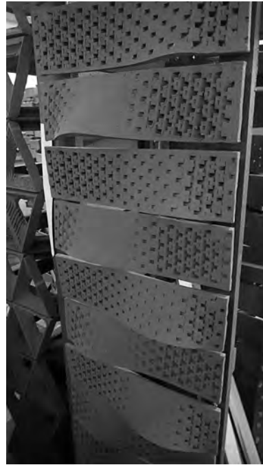
Bild 4. Hong Kong University, Ziegel-Wandverkleidung, Detail
