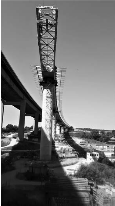
Bild 11. Längseinschub (© 2016 Donges SteelTec GmbH)
