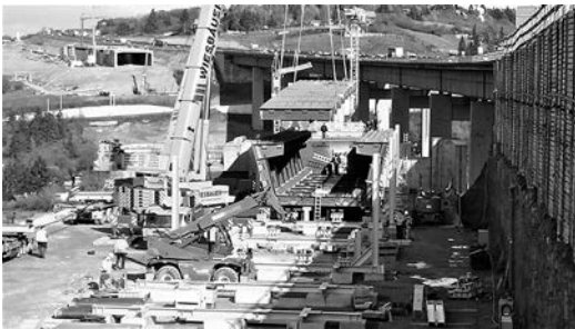
Bild 8. Zusammenbau des Trapezkastens auf dem Vormontageplatz, (© 2016 Donges SteelTec GmbH)
