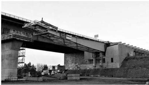
Bild 10. Vorbau schnabel mit Hubtisch vor erstem Vershub (© 2016 Donges SteelTec GmbH)
