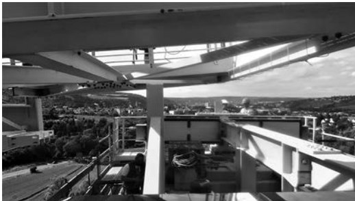
Bild 12. Auflaufen des Vorbauschnabels mit Hubtisch beim 120 m Kragarm (© 2016 Donges SteelTec GmbH)
