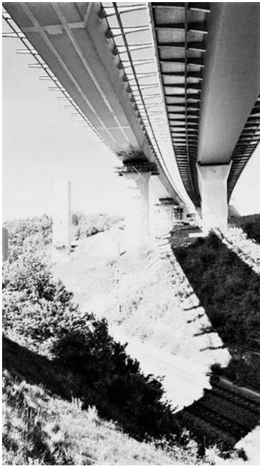
Bild 19. Überbau Rifa FRA mit und Rifa WÜ ohne Fahrbahnplatte (© 2019 Donges SteelTec GmbH)
