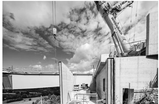
Bild 14. Demontage Vorbauschnabel (© 2016 Tom Bauer – Würzburg)
