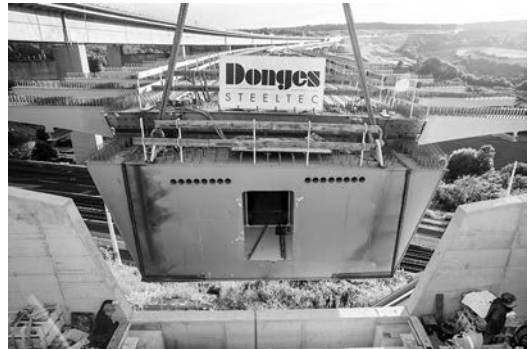
Bild 15. Einfädeln ins Widerlager beim letzten Verschluss (© 2016 Tom Bauer – Würzburg)
