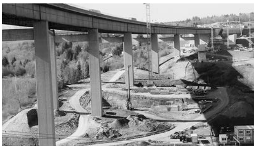
Bild 2. Bestandsbrücke (© 2014 Donges Steeltec GmbH)
