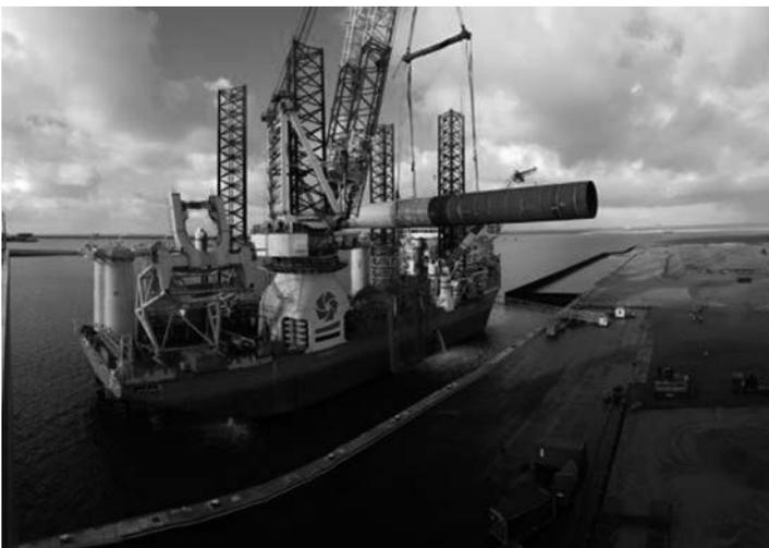
**Abb. 7.75** Jack-up-Schiff beim Heben eines Monopiles.
