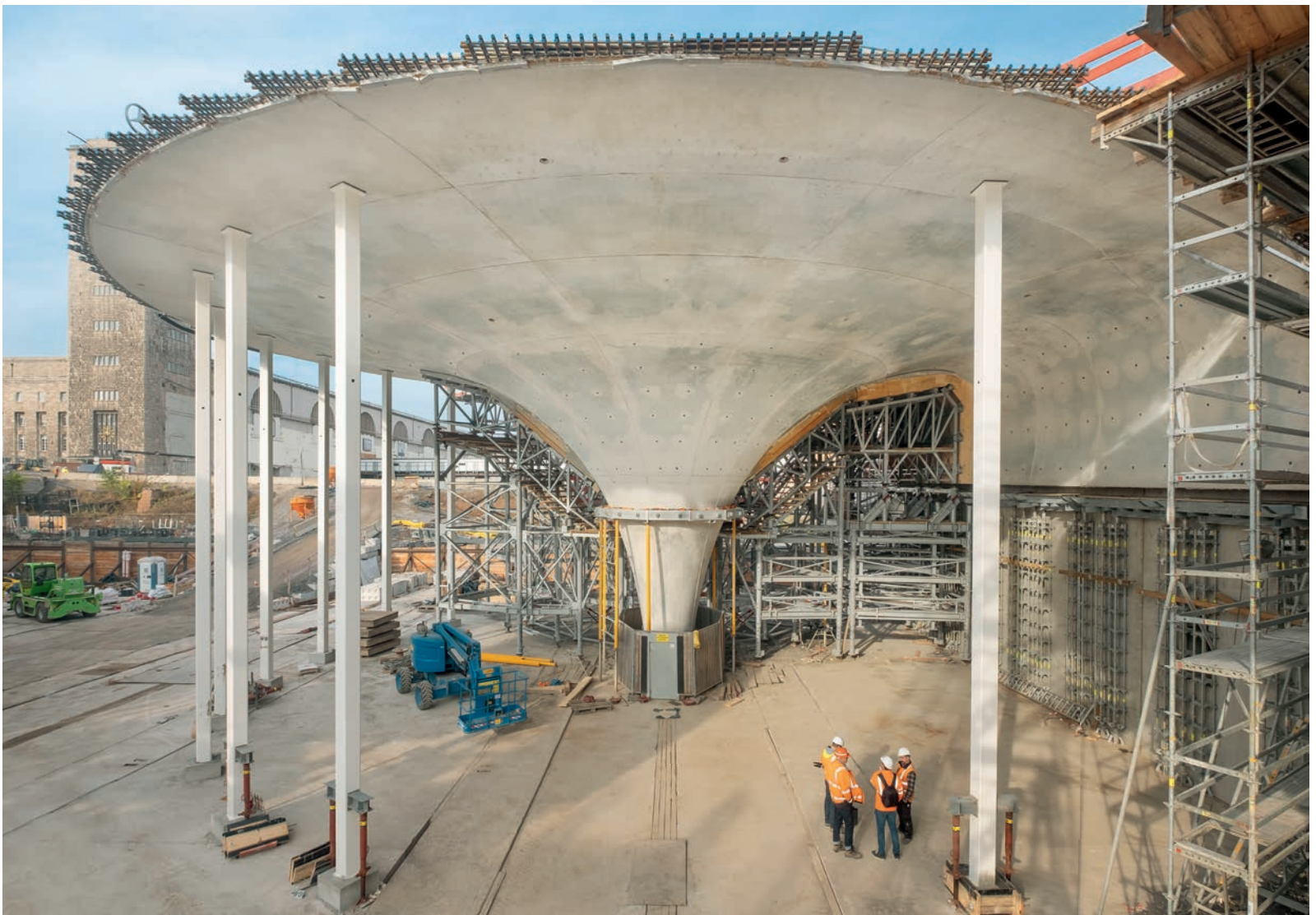
Kelchstütze bei Stuttgart 21, betoniert
