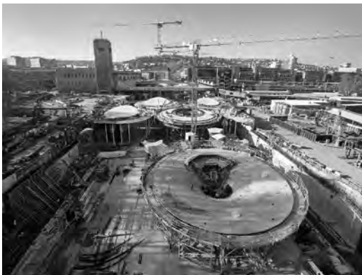
Bild 11. Erste fertiggestellte Kelchstütze (© Achim Birnbaum, Stuttgart)
