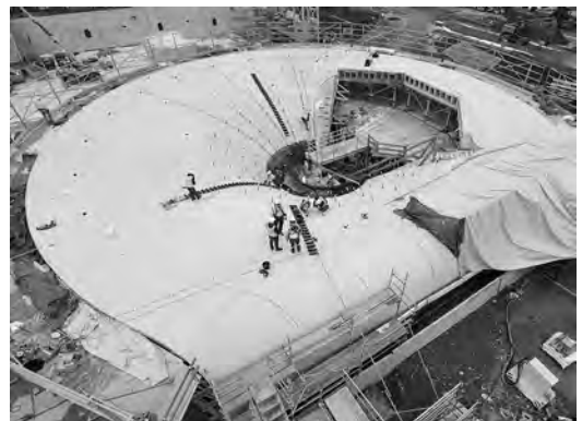
Bild 9. Schalungselemente (© Achim Birnbaum, Stuttgart)
