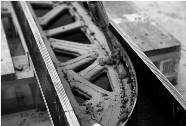
Bild 29. Herstellung eines Betonträgers, Entwicklungsstufe 4 (Beton: PrintCret 230, Bewehrung: Stahlband S235) mittels 3-D-Betondruck
