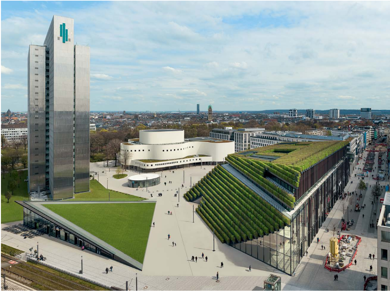
1 Intensive innerstädtische Nachbarbebauung und Infrastruktur
