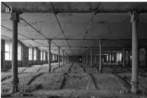
Bild 13. „Alte Aktienspinnerei“ in Chemnitz (aktuelle Nutzung des Gebäudes als Bibliothek). Basierend auf einem Naturbrandszenario wurde eine Feuerwiderstandsdauer von 60 Minuten für die Zuggliedunterspannungen der Gewölbedecken durch den Einsatz eines RBS erreicht; a) Entkernung Westflügel, b) Westflügel nach Sanierung (Fotograf: Till Schuster; Bauherr: Freistaat Sachsen Sächsisches Staatsministerium der Finanzen, vertreten durch den Staatsbetrieb Sächsisches Immobilien- und Baumanagement Niederlassung Chemnitz)
