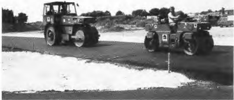
Bild H6 Verdichten von Walzasphalt
