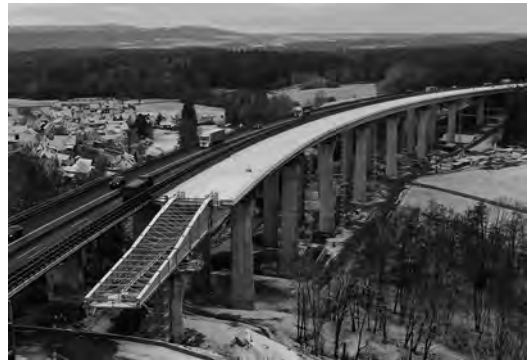
Bild 2. Herstellung der Talbrücke Unterrieden BAB 3 im Taktschiebeverfahren (Foto: Autobahn des Bundes GmbH)
