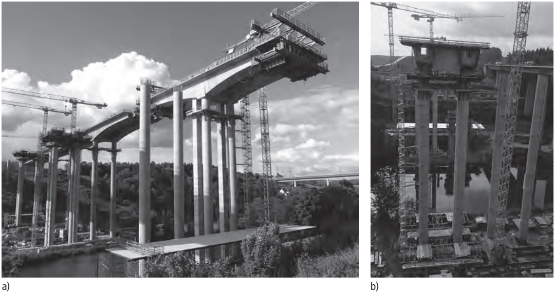
Bild 1. Ersatzneubau Lahntalbrücke Limburg BAB 3; a) Herstellung im Freivorbauverfahren mit temporären quadratischen Hilfsstützenpaaren zur Waagebalkenstabilisierung, Achsabstand zu den runden Hauptpfählern 4,55 m; b) doppelter, über die Fahrbahnplatte gekoppelter Hohlkastenquerschnitt, Querverschub der Hilfsstützenpaare auf Fundamentbalken/Verschubbahn für die zweite Richtungsfahrbahn (Fotos: Büchting + Streit AG)
