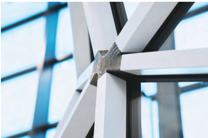
Bild 11 3D-gedruckter Knoten in Musterfassade (© Jansen AG)
