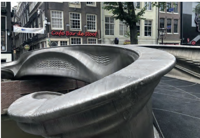
Bild 5 Mittels 3D-Druck hergestellte Brücke | Amsterdam, NL (© keystone)
