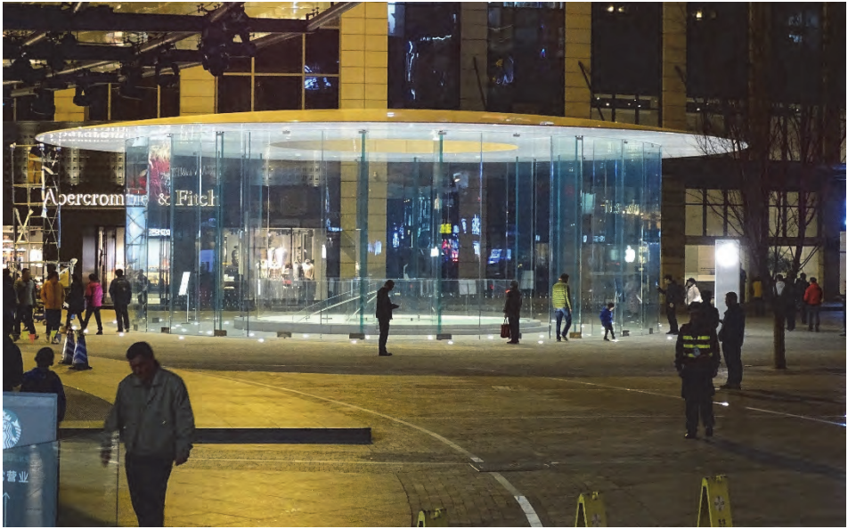
Bild 2 Flagshipstore, Gesamtansicht mit offenen Türen (© Fassadenbauer)
