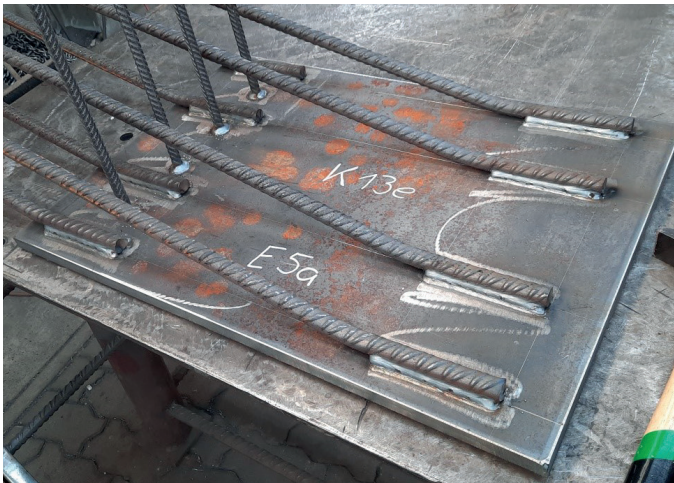
Bild 19: Beispiel für eine geschweißte Flankenkehlnaht
