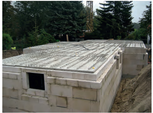
Bild 3. Kellergeschoss im Rohbau. Rechts auf der Baugrubensohle ist der Rand der Bodenplatte mit wärmedämmender Kimschicht sichtbar. Am Wandkopf der Kelleraußenwand – unterhalb der Elementplatten – ist ein der späteren Geländeoberkante angepasster Rücksprung von 36,5 cm auf 17,5 cm Wandstärke zur Auflagerung der Verblendschale zu erkennen. Das Kelleraußenmauerwerk besteht aus Kalksand-Planelementen der Abmessungen 498 mm × 498 mm (L × H). (Foto: Gigla)
