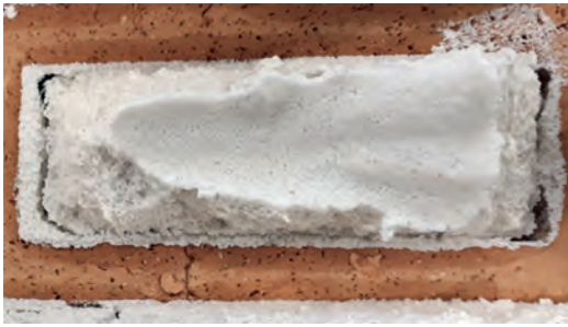
Bild 2. Destabilisierter Mineralschaum in einem Hochlochziegel infolge der Wassermigration (Foto: IAB)
