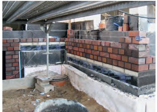
Bild 4. Gründung der Verblendschale, Sockeldetail. Ganz außen eine Perimeterdämmung. Das Kelleraußenmauerwerk ist mit Bitumen-Dachdichtungsbahnen abgedichtet. Auf dem Rücksprung am Wandkopf des Kelleraußenmauerwerks unterhalb der Verblendschale sind Wärmedämmelemente aus geschäumtem Glas mit geschlossenzelliger Struktur und eine Höhenausgleichsschicht aus Kalksandsteinen angeordnet. Die Dichtungsebene wird unter dem Wärmedämmelement zur Tragschale geführt und ist hinter der Verblendschale zu erkennen. Die spätere Geländeoberkante liegt ungefähr auf Höhe der obersten fertiggestellten Lage der Verblendschale. (Foto: Gigla)
