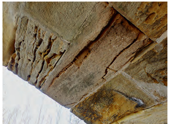
Bild 2. Patinabildung im aufgehenden Widerlagerbereich mit Abwitterungen unterhalb des Gewölbebogens
