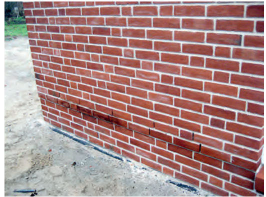
Bild 7. Verblendschale im sog. „wilden Verband“, nachverfugt. In der Steinreihe oberhalb des Sockels ist hier infolge zeitweiliger starker Durchfeuchtung eine schwarze Verfärbung durch Mikroorganismen eingetreten. (Foto: Gigla)
