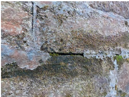
Bild 2. Patinabildung im aufgehenden Widerlagerbereich mit Abwitterungen unterhalb des Gewölbebogens
