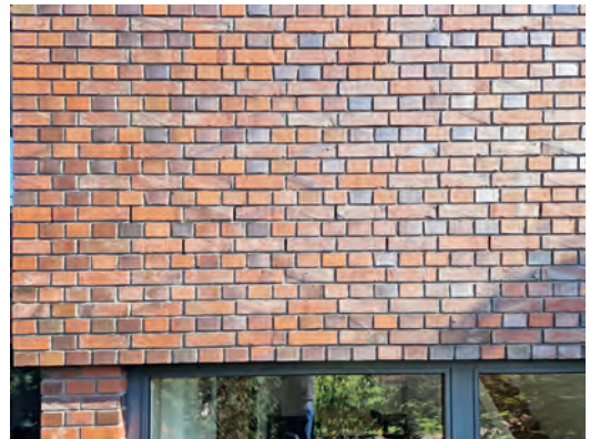
Bild 8. Verblendschale im „Blockverband“, Fugenglattstrich. Oberhalb der Verblendschale im Stützenbereich ist eine horizontale Dehnungsfuge erforderlich. Die Ausführung von Rücksprüngen – wie hier im Bereich des Eckpfeilers – setzt eine sorgfältige Planung im Hinblick auf den energiesparenden Wärmeschutz voraus. (Foto: Gigla)
