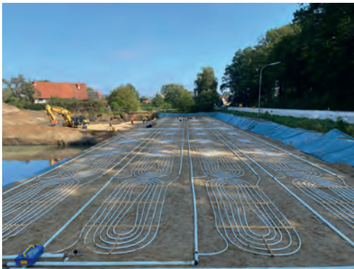
Bild 12. Flächenkollektor (aus [8])
