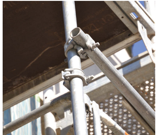
Bild 5. Verbindung zweier Rohre mit einer Normalkupplung (Foto: Bügler)
