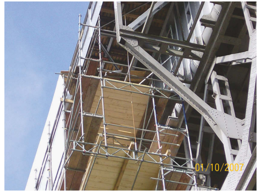
Bild 2. Hängegerüst mit flächenorientierten Gerüstlagen (Foto: Bügler)
