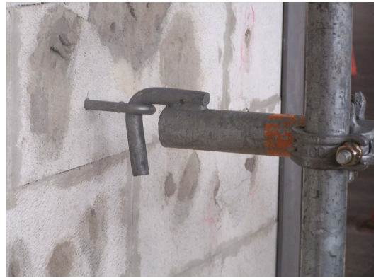
Bild 6. Verankerung eines Fassadengerüsts mit kurzem Gerüsthalter und Ringöschenschraube (Foto: BIZWA Bernau)
