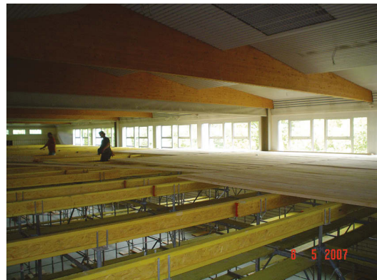
Bild 3. Raumgerüst als Standgerüst mit flächenorientierten Gerüstlagen (Foto: Bügler)
