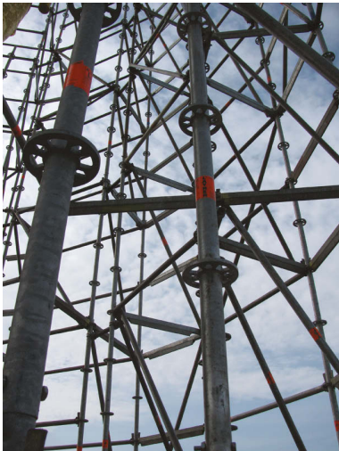
Bild 4. Modulgerüst (Foto: Bügler)
