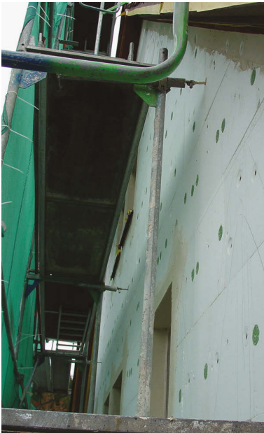
Bild 12. Befestigung eines Arbeitsgerüsts mit langen Ringöschenschrauben bei Montage eines WDVS-Systems (Foto: Küenzlen)
