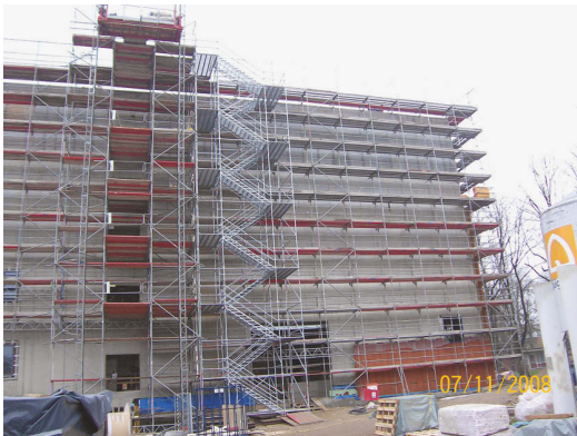
Bild 1. Rahmengerüst als Standgerüst mit längenorientierten Gerüstlagen, Fassadengerüst (Foto: Bügler)
