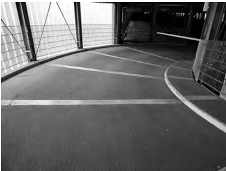
Bild 8. Beispiel für zwangarm gelagerte Rampenplatten (Systemparkhaus) nach Variante A2
