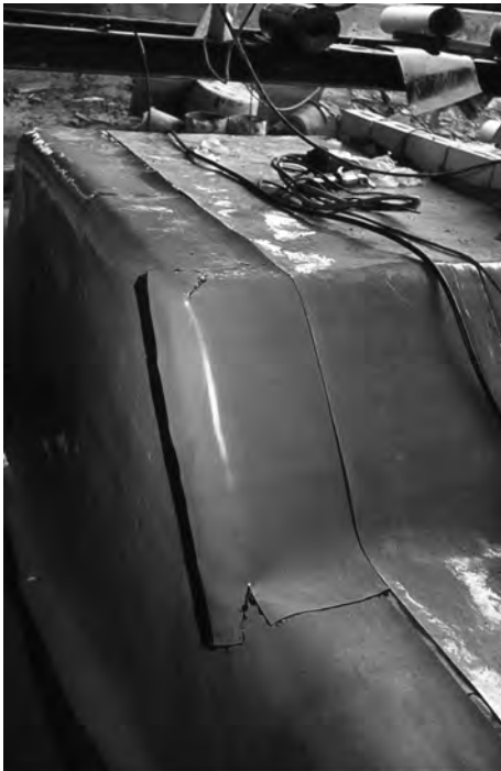
Bild 1. Deckenabdichtung mit ECB-Dichtungsbahnen im U-Bahn-Bau
