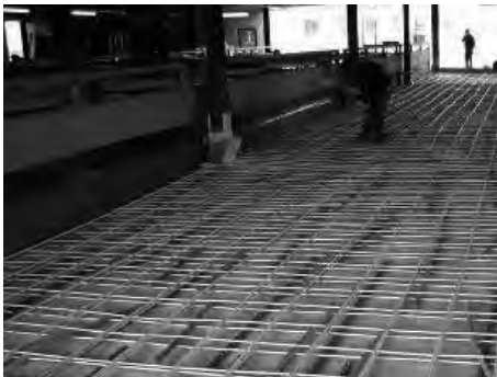
Bild 6. Beispiel Variante Rostfrei: GFK-Bewehrung im Parkdeck (Foto: Schöck Bauteile GmbH)
