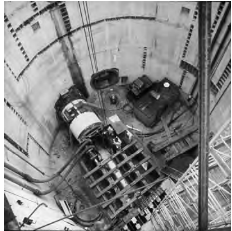
Bild 3. Kanalbau mit Stahlbetonvorpressrohren
