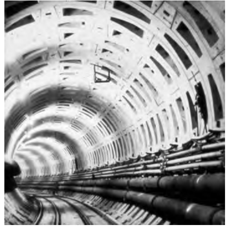
Bild 2. Fugendurchsetzter Tunnelausbau mit Stahlbetonkassettentübbings
