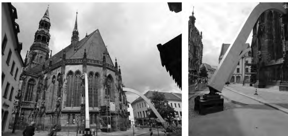
Bild 13. Temporäre Abstützung der Pfeiler M1 und M2 im Juni 2016
