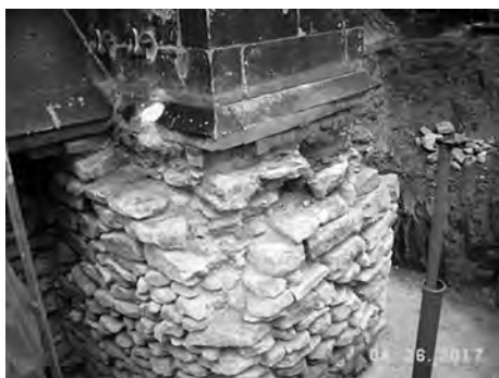
Bild 12. Bestandsfundament nach oberflächiger Reinigung (Foto: Michael Kühn)
