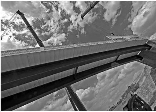
Bild 23. Stahlbrücke mit aufgeklebter Fahrbahn aus glasfaserverstärktem Kunststoff (© Fiberline Composites)
