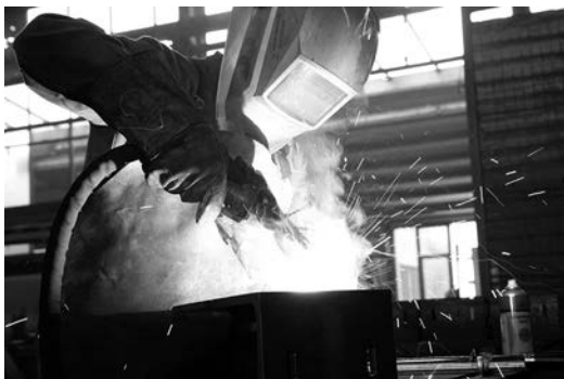
Bild 17. Schweißarbeiten, parallele digitale Dokumentation (© Firma Lacker)
