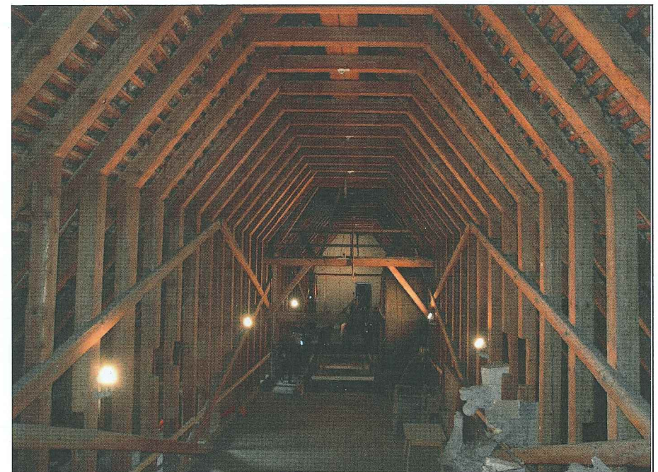
Konstanz, Münster, Dachwerk über dem Langhaus von 1223-36 bis 1239 (d), Blick nach Osten. Das relativ steile romanische Sparrendach hat senkrechten Sparrenstützen und ist mit angeblätternen diagonalen Streben ausgesteift. Im Hintergrund rechts ist ein erhaltenes Tretrad für den Transport von Baumaterial zu sehen. Foto: Thomas Eißing, 2010.
