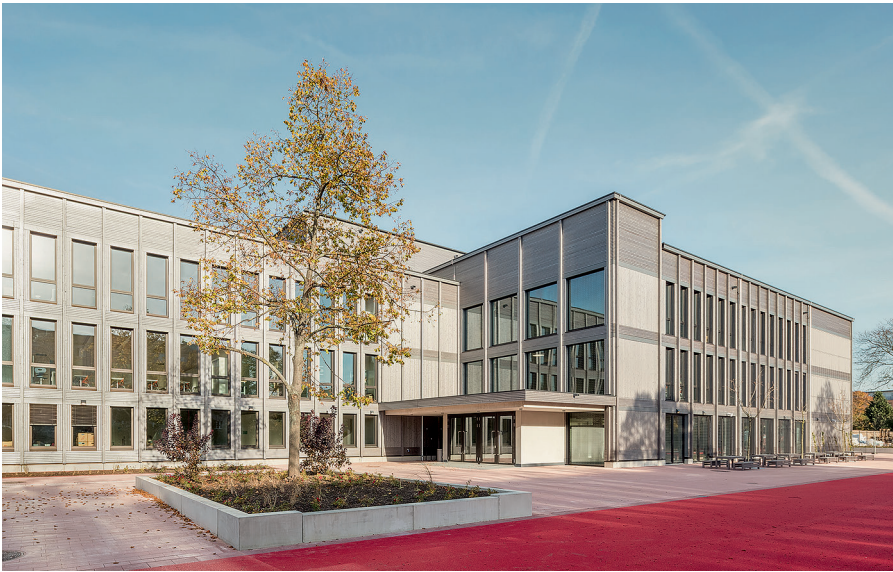
Bild 1 Die 33. Grundschule in Dresden-Seidnitz für 240 Kinder in vier Klassenzügen; der Neubau wurde in Hybridbauweise aus 112 Holzmodulen und Elementbauteilen erstellt
