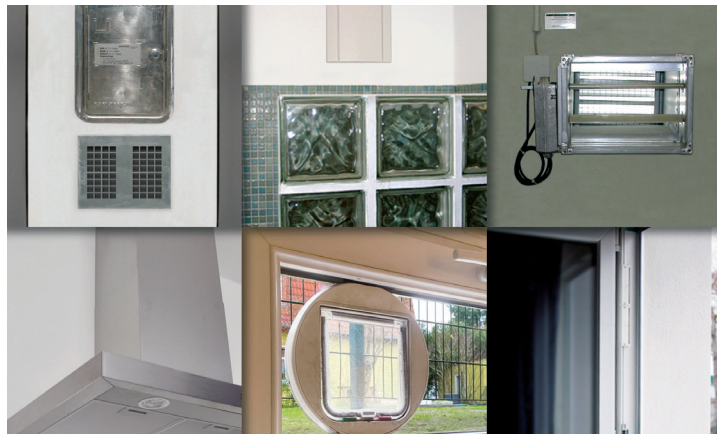
Kaminhinterlüftung, Abluftöffnung im fensterlosen Bad, Fahrtschachtbelüftung, Ablufthaube, Katzenklappe und ein der freien Lüftung dienender Fensterfalzlüfter (von oben links) sind Beispiele von Öffnungen in der Gebäudehülle, die man für GEG-Schlussmessungen nicht abdichten darf.
