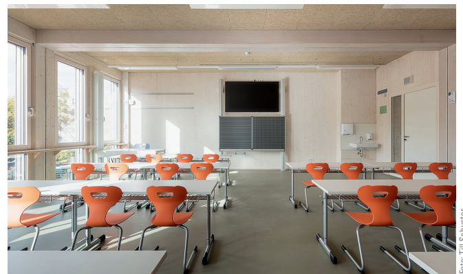
Bild 3 Die Klassenzimmer sind aus je drei vorgefertigten Holzbau-Raummodulen zusammengesetzt. Für eine einheitliche Optik wurden Holzinnenwände und Unterzüge weiß lasiert.
