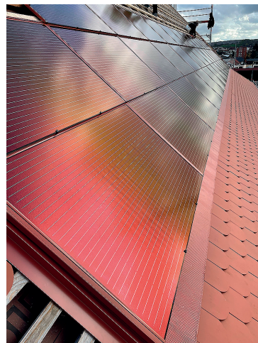
Bild 2 Nahaufnahme der Dachintegration ziegelroter Photovoltaikmodule
