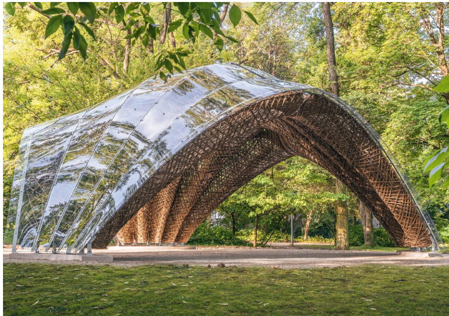
livMatS Pavillon: Außenansicht
