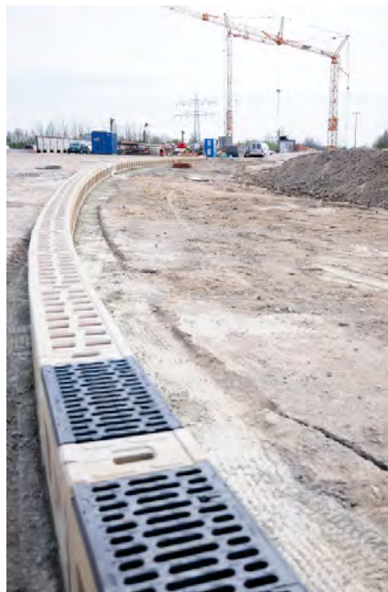
Bild 2 Im Bereich der Auffahrt HH-Schnelsen-Nord (Richtung Süden) gewährleistet ein Rinnenstrang aus ACO DRAIN® Monoblock RD 200 V OPA eine schnelle und sichere Entwässerung. Auch im Kurvenbereich sind die Rinnenstöße durch die integrierte EPDM-Dichtung dicht.
