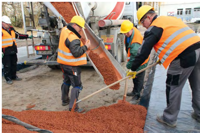
Bild 1 Der Fahrmischer liefert den Dränbeton Pervia® direkt zum Einbauort.
