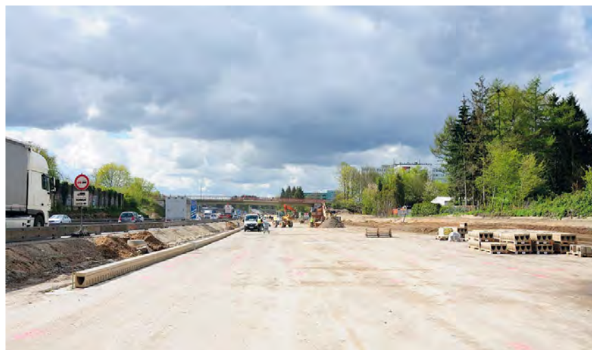
Bild 1 Bei Norddeutschlands größtem Straßenbauprojekt werden ACO Entwässerungsrinnen eingesetzt.
