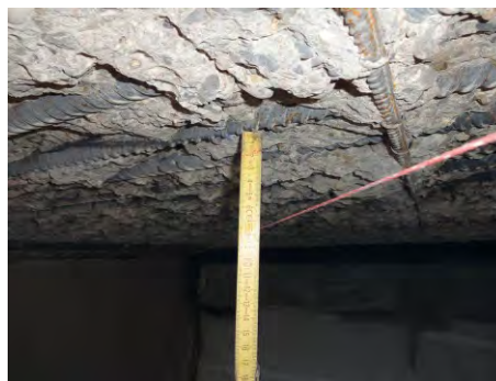
Bild 5 Vorbereitung für das Aufbringen einer bewehrten Spritzbetonschale auf der Brückenunterseite
