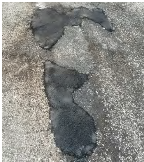
Bild 2 Echte Asphalt-sieblinie, niedriger Hohlraumgehalt, bei gleichzeitig schneller reaktiver Aushärtung wurden vom Prüflabor bestätigt.
