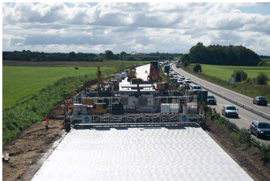
Bild 2 Betonfertiger auf der ARGE A7 Hamburg-Bordesholm
