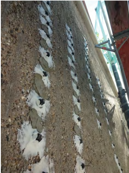
Bild 6 Kraftschlüssige Rissverpressung mit Epoxidharz.
