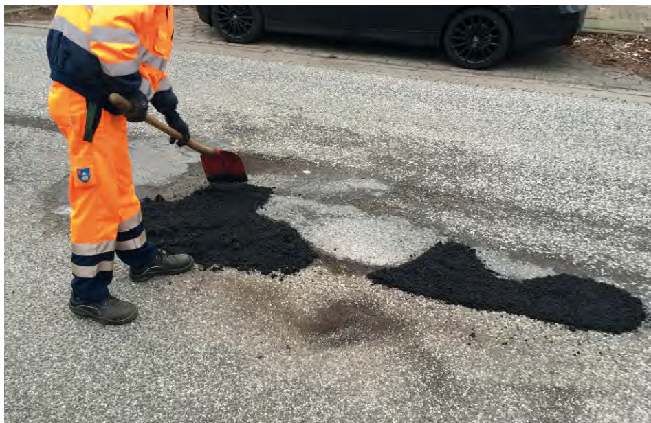
Bild 1 Anders als bei herkömmlichen Kaltmischgütern, wird die Schadstelle mit INNOPHALT® regelrecht versiegelt.
