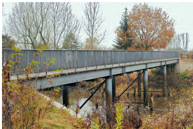
Bild 2 Die 1977 gebaute, 43 m lange Brücke ist Deutschlands erste feuerverzinkte Straßenbrücke.
