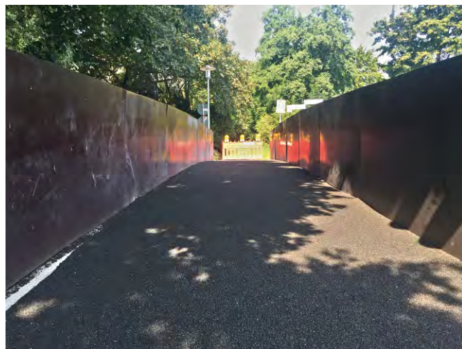
Bild 2 Durch Einsatz der PMMA-Systemkomponenten konnte nach drei Tagen Sperrzeit die Brücke wieder freigegeben werden.
