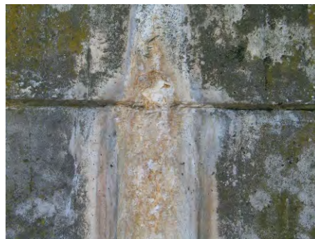
Bild 3 Aussinterungen an den Stützwänden
