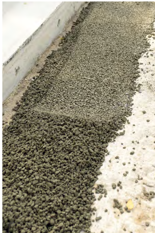
Bild 2 Die Pervia®-Produktfamilie sorgt für ungehindertes Versickern von Regenwasser. Voraussetzung ist, dass die Deckschicht und die Tragschicht aus wasserdurchlässigem Material gebaut wurden.
