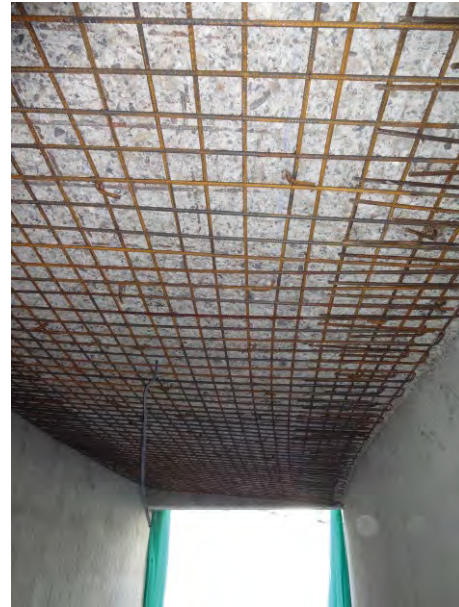
Bild 7 Bewehrte Spritzbetonschale an der Deckenunterseite des Spindelbauwerks
