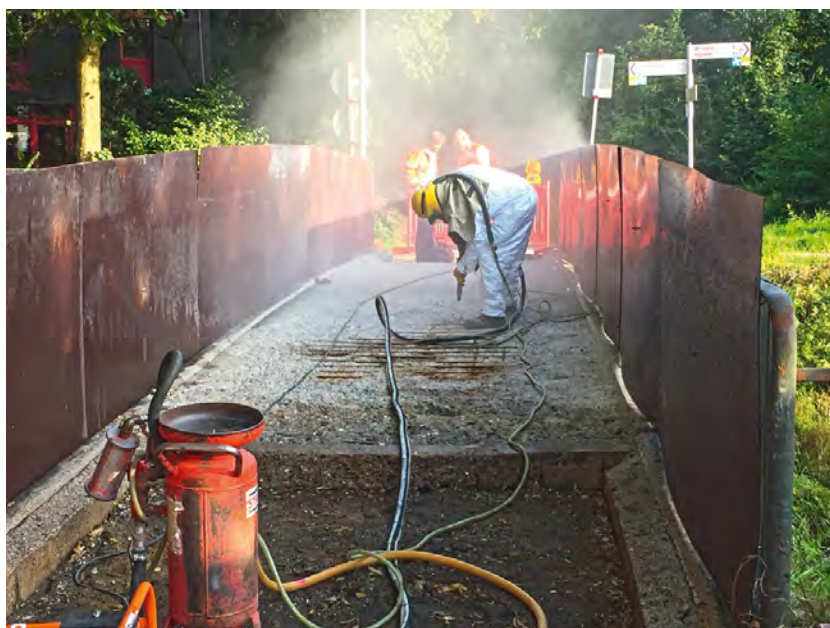
Bild 1 Ein Teilbereich der Betonoberfläche war soweit geschädigt, dass die Bewehrung freigelegt wurde.
