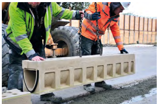
Bild 3 Das geringe Gewicht der 2-m-Elemente aus Polymerbeton ermöglicht eine Verlegung mit leichten Hebemaschinen.
