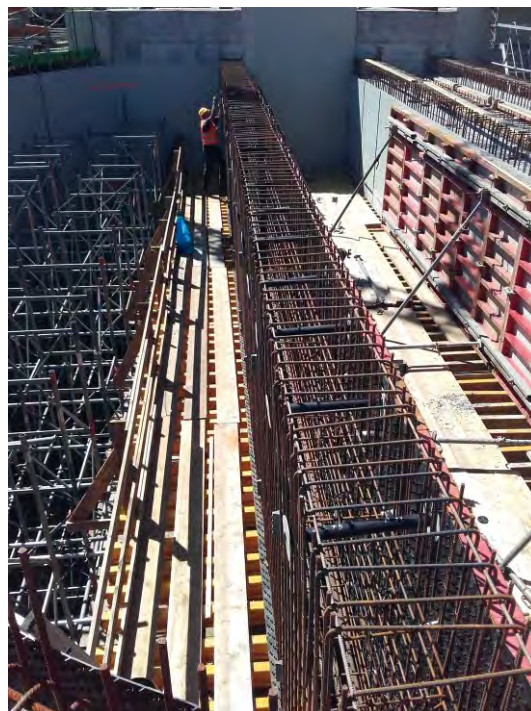
Bild 2 Traggerüststellung für Unterzüge und Deckel
