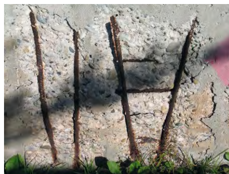
Bild 4 Korrodierte Stahleinlagen am Spindelbauwerk. Die Betondeckung ist zu gering.
