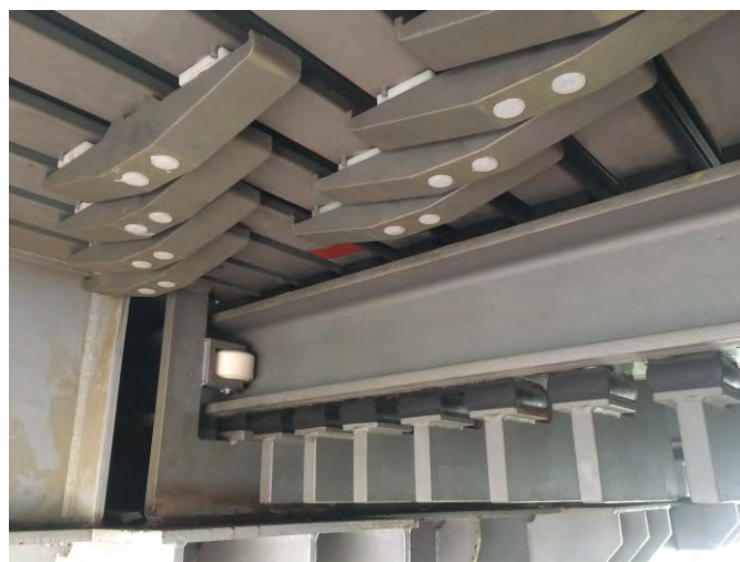
Bild 3 Die neu entwickelte Steuerung der Gleitlamellen-Dehnfugen.
