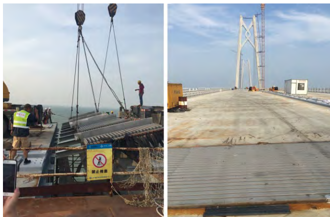
Bild 1 Links: Einfädeln einer gekippten Dehnfuge in die vorgefertigten Aussparungen. Rechts: Die neuen Gleitlamellen-Dehnfugen wurden an den Hauptsegmenten der Jianghai-Schrägseilbrücke eingebaut.
