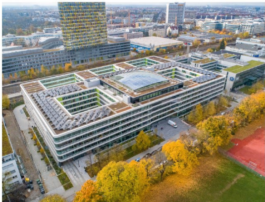
Nachhaltigkeit trägt zur Wertstabilität bei: In München generieren die Solarzellen des Newton-Bürogebäudes haus eigene Energie
