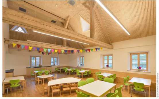
Bild 1 Ob Dachkonstruktion, Holzwole-Akustikdecken, Fußböden oder Mobiliar – Holz ist allgegenwärtig in der Kindertagesstätte Stein und nimmt rd. 90 % der insgesamt verarbeiteten Materialien ein
