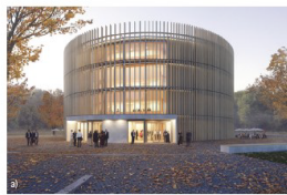
Bild 1 Visualisierung (a) und Realisierung (b) des viergeschossigen Globe Theaters: der Eingangsbereich zeigt sich hell erleuchtet und öffnet sich innen nach oben über alle Geschosse; für den Blick von innen nach außen hat man die Abstände der Lamellen der Fassade groß gewählt
