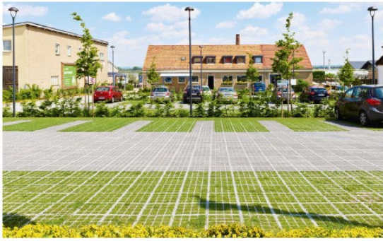
Versickerungsfähige Flächen leisten einen positiven Beitrag zum Stadtklima – mit dem TTE-System lässt sich dieses Potential voll ausschöpfen
