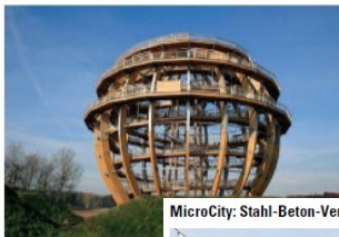
Bild 1 Die begehbare Kugel ist ein ca. 200 t feuerverzinktem Stahl
