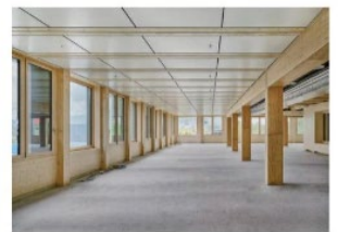
Bild 3 Der Innenraum ist geprägt von Buchenholzstützen und -balken, kombiniert mit einer hellen Deckenunterseite, darüber verlagert sich das multifunktionale Verbunddeckensystem mit vorkonfigurierten Leitungen für die Haustechnik
