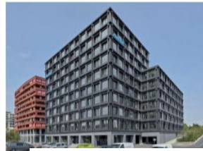
Bild 1 Sozialer Wohnungsbau in Hybridbauweise: zwei mehrgeschossige Gebäude in nur acht Wochen
