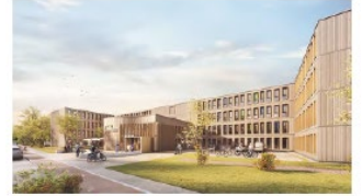
Bild 4 Für den Neubau des Verwaltungsgebäudes der Kreisverwaltung Mainz-Bingen lieferte die HASSLACHER Gruppe in Summe 50 m 3 Brettspertholz mit einer Exzellentoberfläche in Birke und ca. 313 m 3 Birke-Brettschichtholz inkl. Abbund
