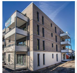
Bild 2 Die Gebäude wurden in Hybridbauweise mit Holz und Beton
