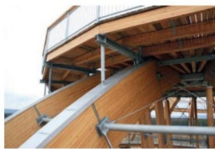
Bild 2 Sämtliche Stahl- und Metallbauteile wurden dauerhaft feuerverzinkt
